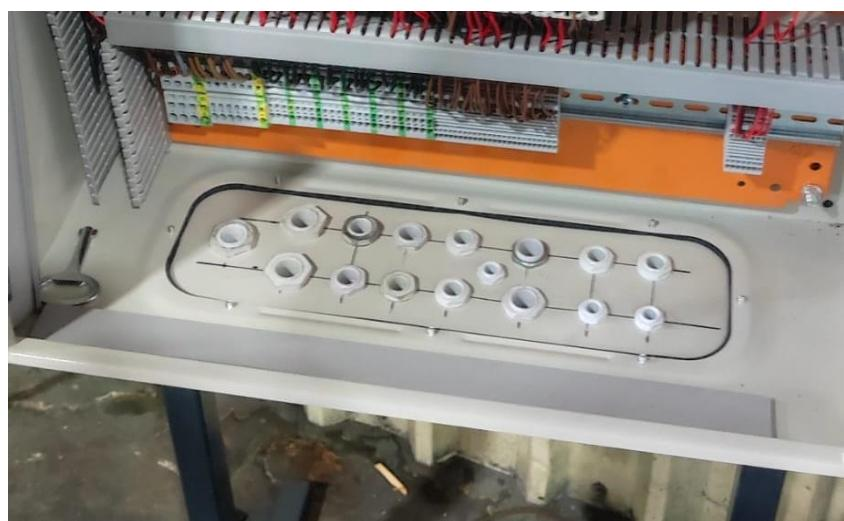
*Slika 4.5. Postavljene uvodnice u novom ormaru*
