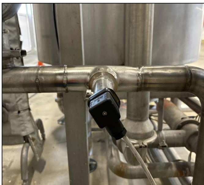
Slika 3.4 Pozicija transmitera tlaka
