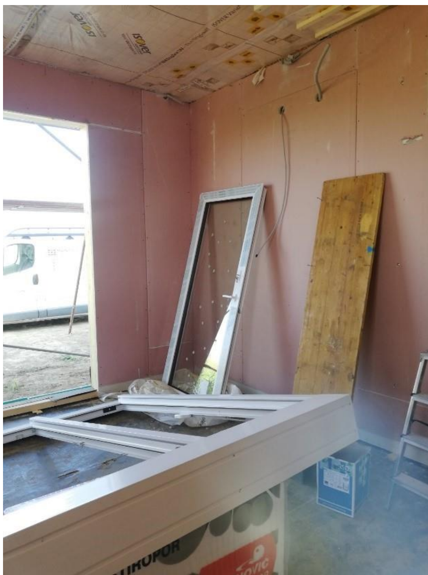
Slika 6.12. Ugradnja stolarije – Unicef objekti (izvor: Pomoćnik inženjer gradilišta Ivan Ploh - HIDROING d.o.o.)
