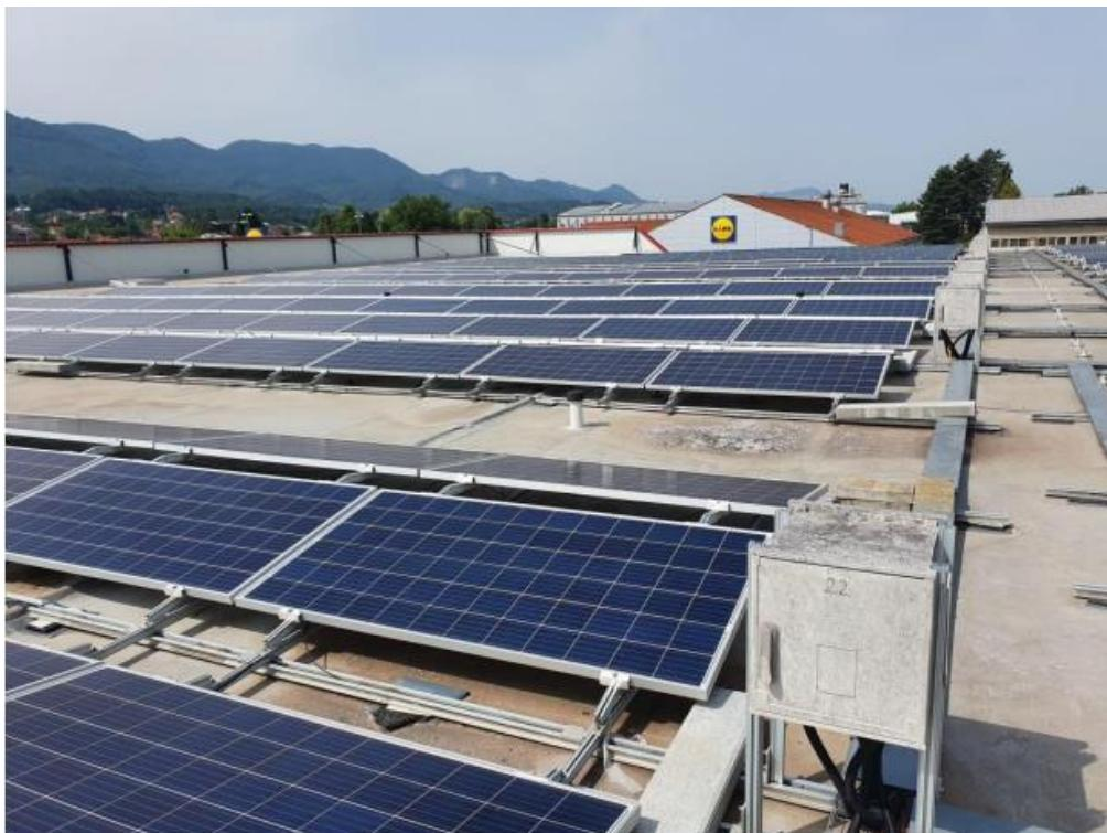
*Slika 3.1 Solarne fotonaponske ćelije [12]*
