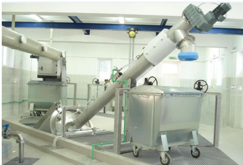
Slika 21. Automatska fina rotacijska rešetka [27]
