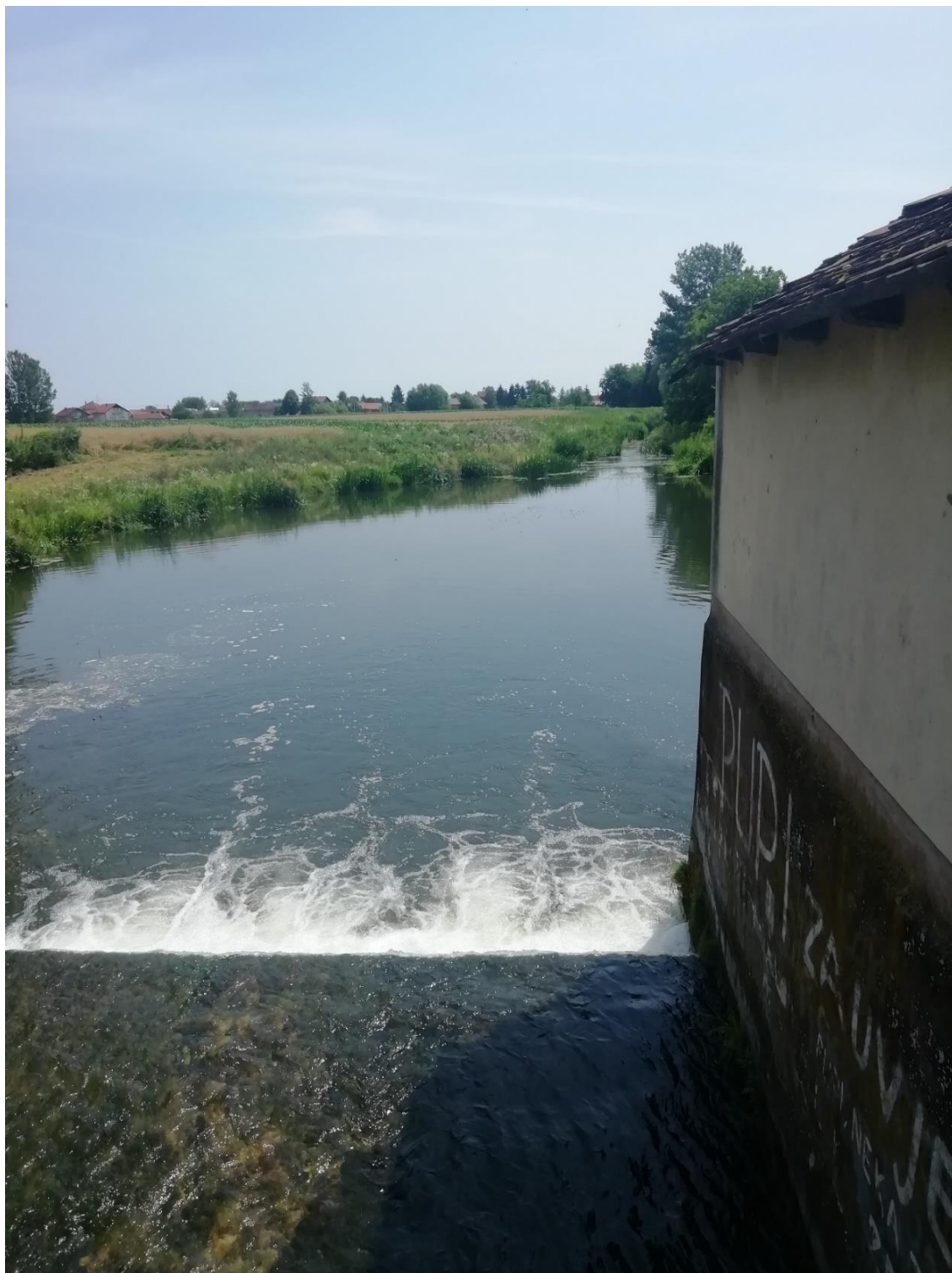
Slika 11. Ulaz vode u jezero vidljiv sa strane zapornice
