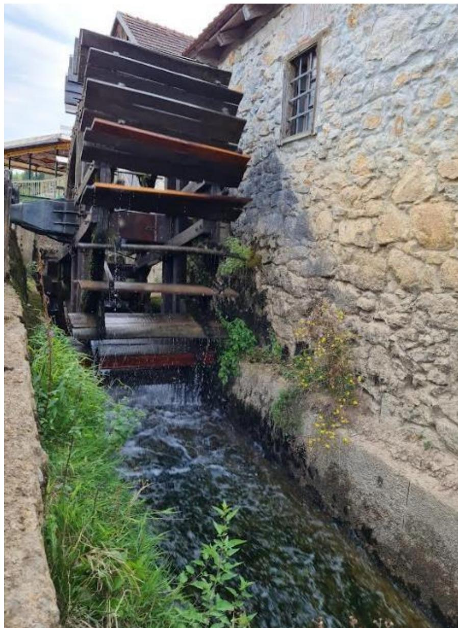
Slika 41. Prikaz izlaza dovodnog kanala [8]
