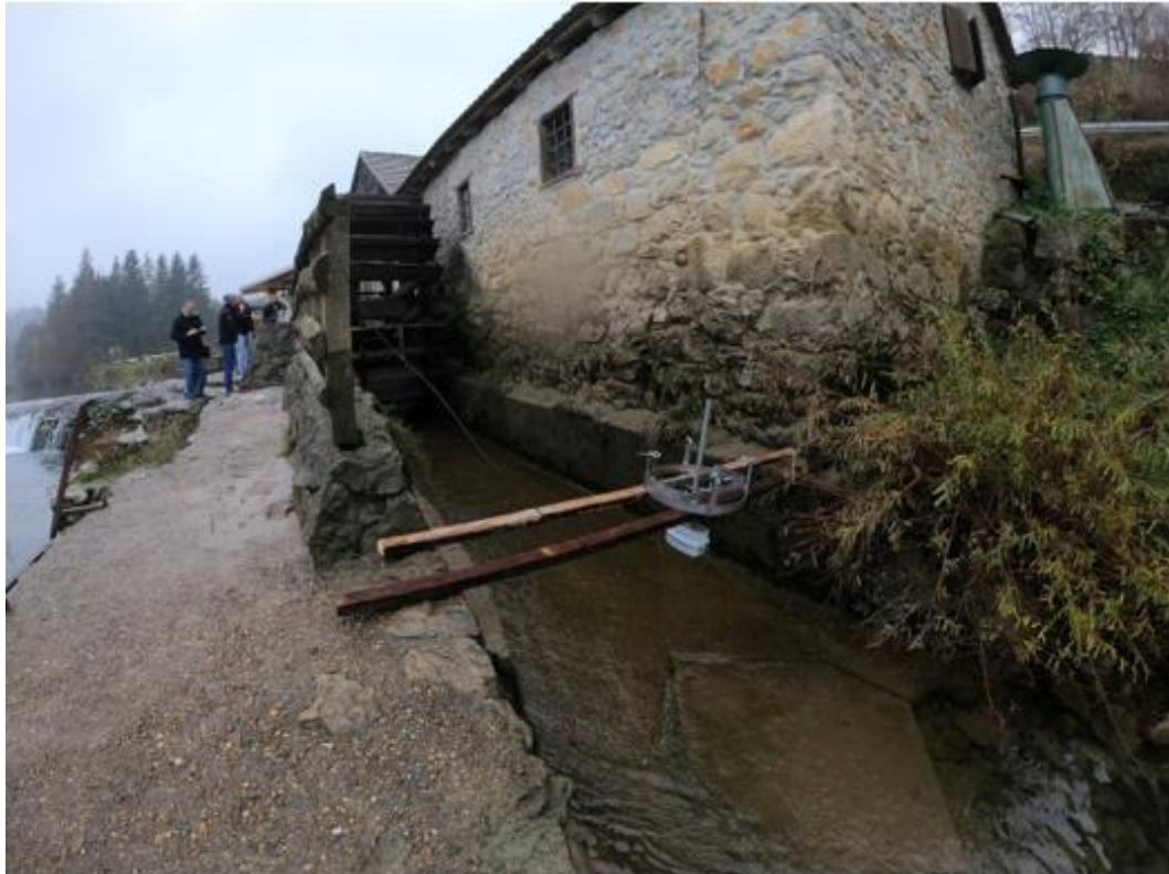
Slika 31. Postavljanje uređaja SQ-R Flow Meter [13]
