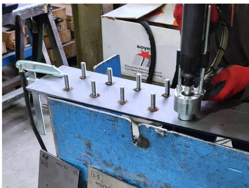
Slika 3.9. Postavljanje pištolja zavarivanja u poziciju zavarivanja
