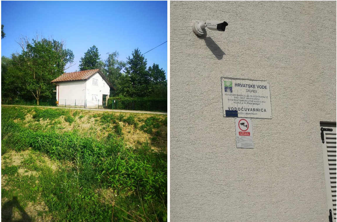
Slika 4.1. Vodočuvrnica kod brane u Kućanu Ludbreškom [12]
