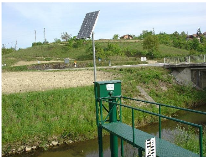
Slika 3.1.1. Vodomjerna stanica Lepoglava [6]
