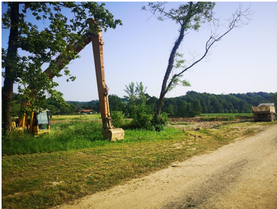
Slika 5.2.6. Građevinska mehanizacija kod rijeke Bednje [12]
