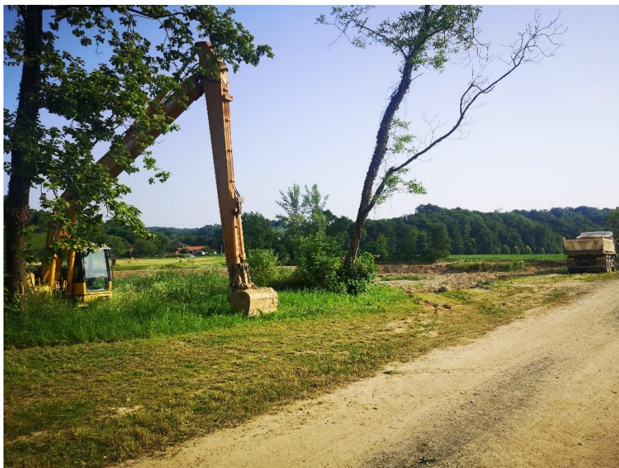
Slika 5.2.6. Građevinska mehanizacija kod rijeke Bednje [12]
