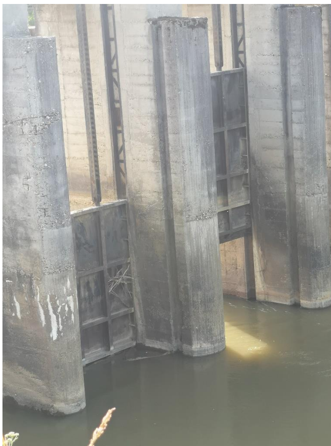
Slika 4.3. Zapornice na brani u Kućanu Ludbreškom [12]
