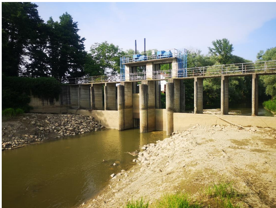
Slika 4.2. Brana u Kućanu Ludbreškom [12]
