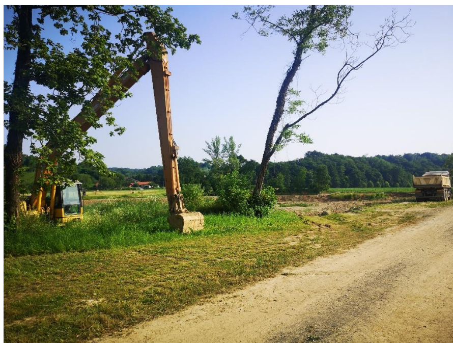
Slika 5.2.6. Građevinska mehanizacija kod rijeke Bednje [12]
