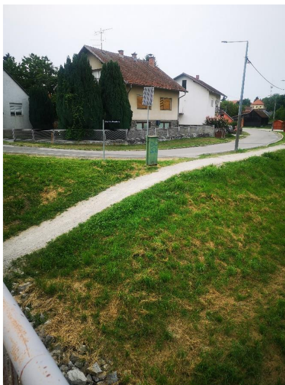
Slika 3.5.1. Vodomjerna stanica Ludbreg [12]
