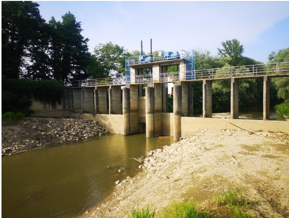
Slika 4.2. Brana u Kućanu Ludbreškom [12]
