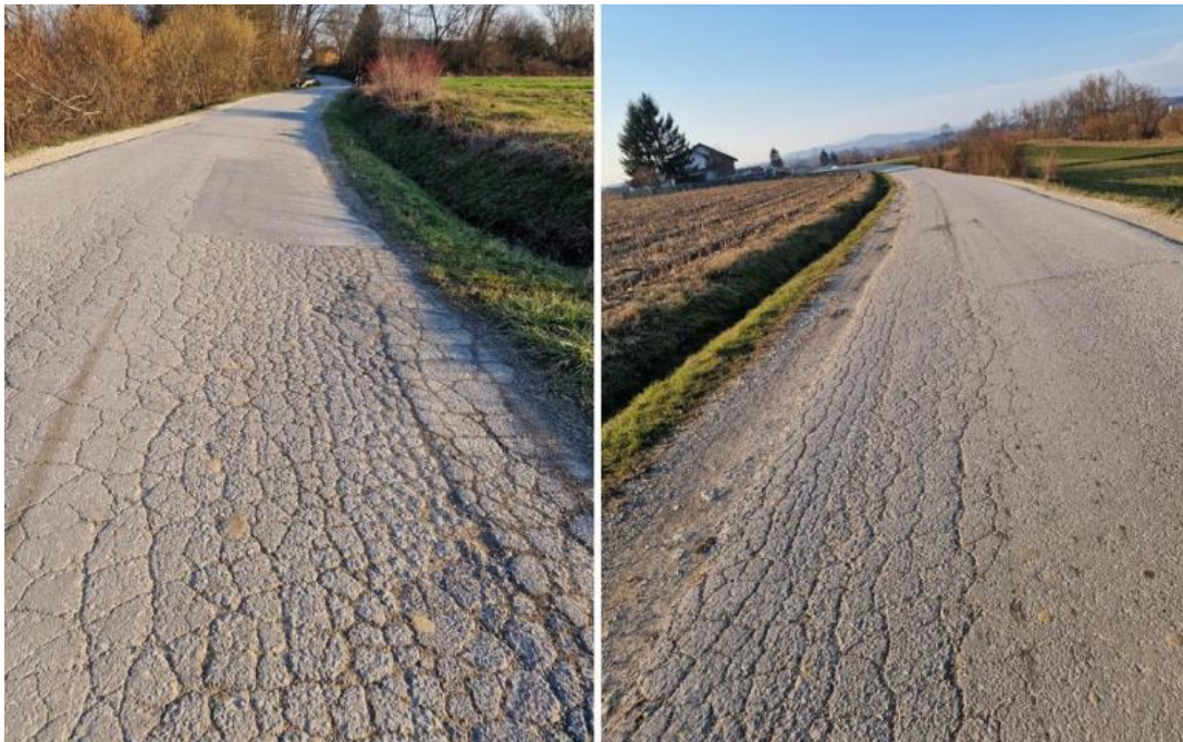
Slika 10. ŽC 3143; Stacionaže: km 4+420 ÷ km 2+420
