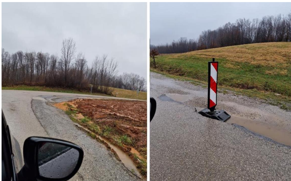
Slika 4. Lokalna cesta LC 34059; Stacionaže: km 0+230 ÷ km 1+610
