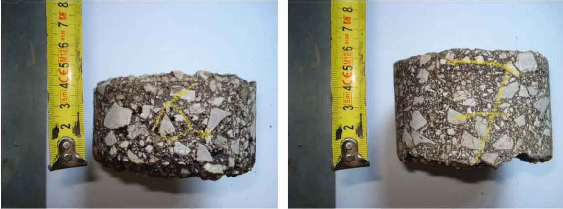
Slika 19. Ispitivanje debljine nosivog sloja (ŽC 3257)
