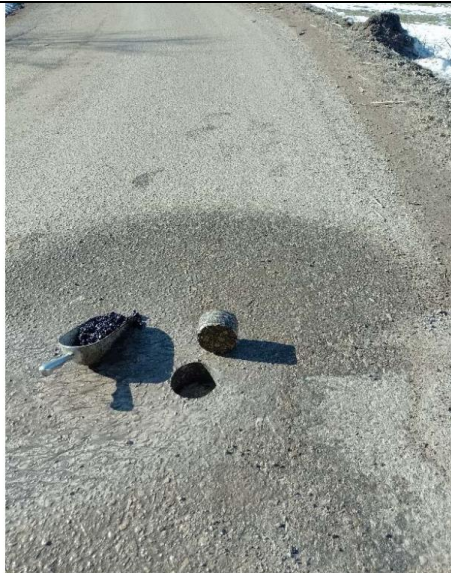
Slika 16. Obilazak županijske ceste ŽC 3257
