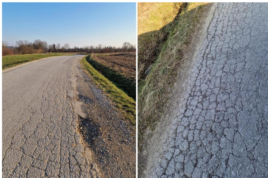
Slika 11. Puzanje bankine i procjeđivanje vode kroz bankinu
