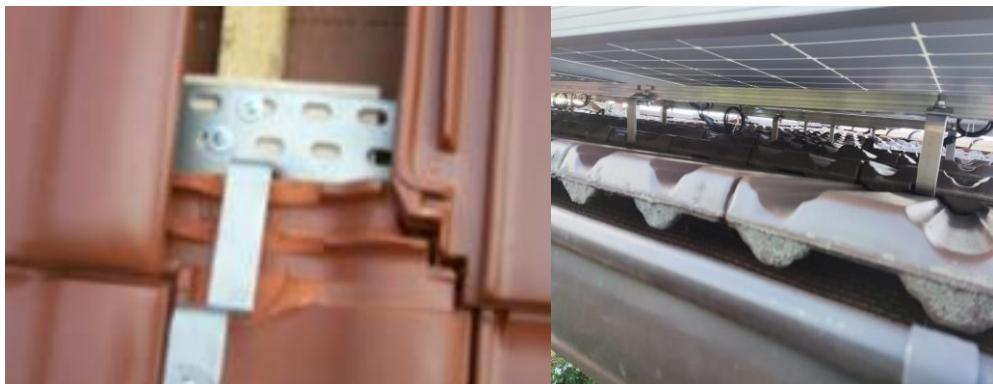
Slika 4.15. Detalj ugradnje krovnog nosača
