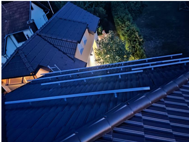
Slika 4.13. Ugrađeni montažni profili na krovnu površinu (priprema za montažu FN-skih modula)
