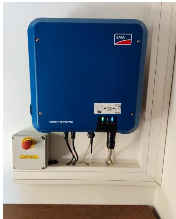
*Slika 4.21. Instalirani predmetni inverter SMA SUNNY TRIPOWER 4.0*
