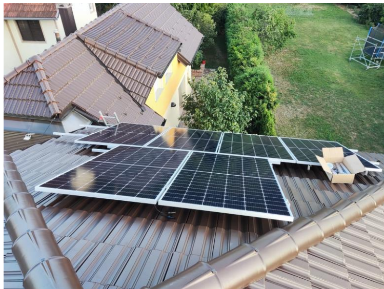
Slika 4.10. Faza montaže FN modula na krovnu površinu
