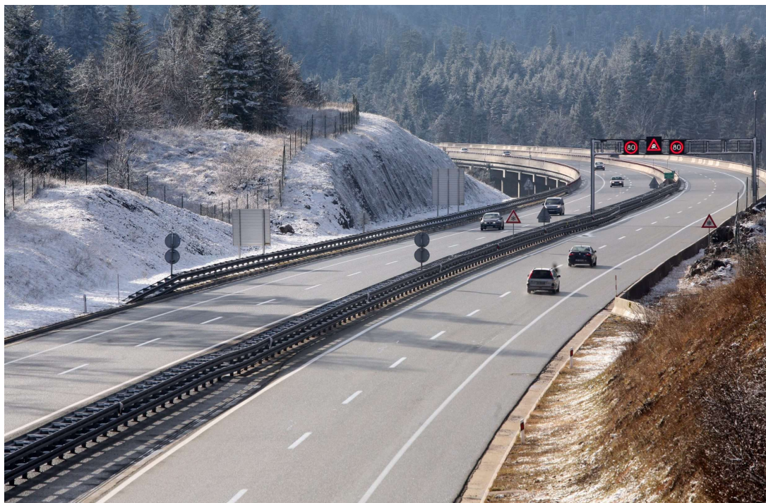
Slika 9. Postojeće stanje dijela dionice na području oko Slemena u smjeru prema Rijeci
