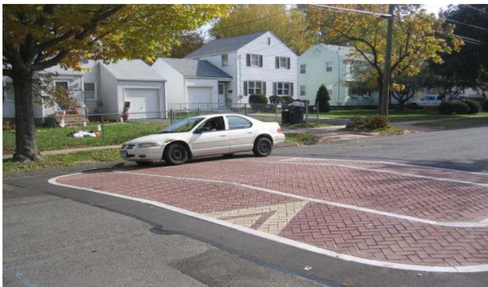
Slika 3-15- Izboćine na kolniku izvedene kombinacijom asfalta i betonskih elemenata
