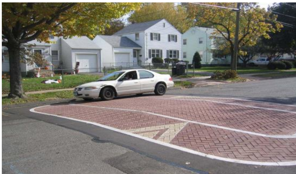
Slika 3-15- Izbočine na kolniku izvedene kombinacijom asfalta i betonskih elemenata
