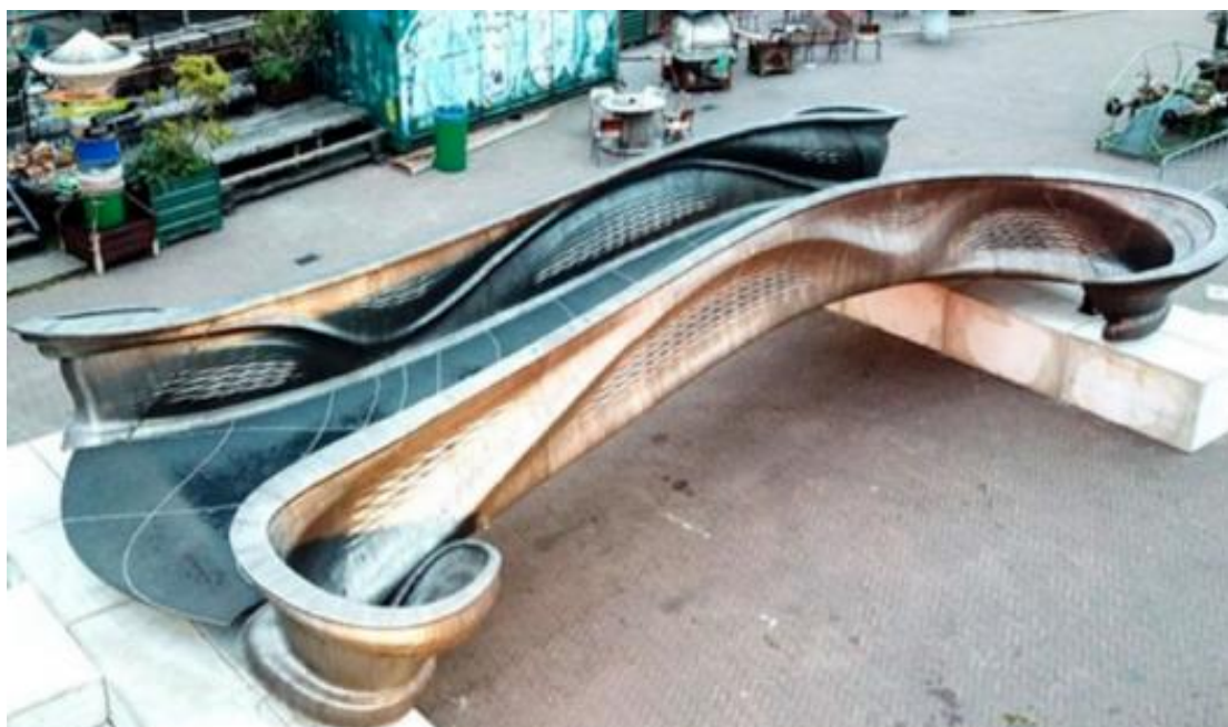
Slika 16. Most izrađen WAAM postupkom [36]
