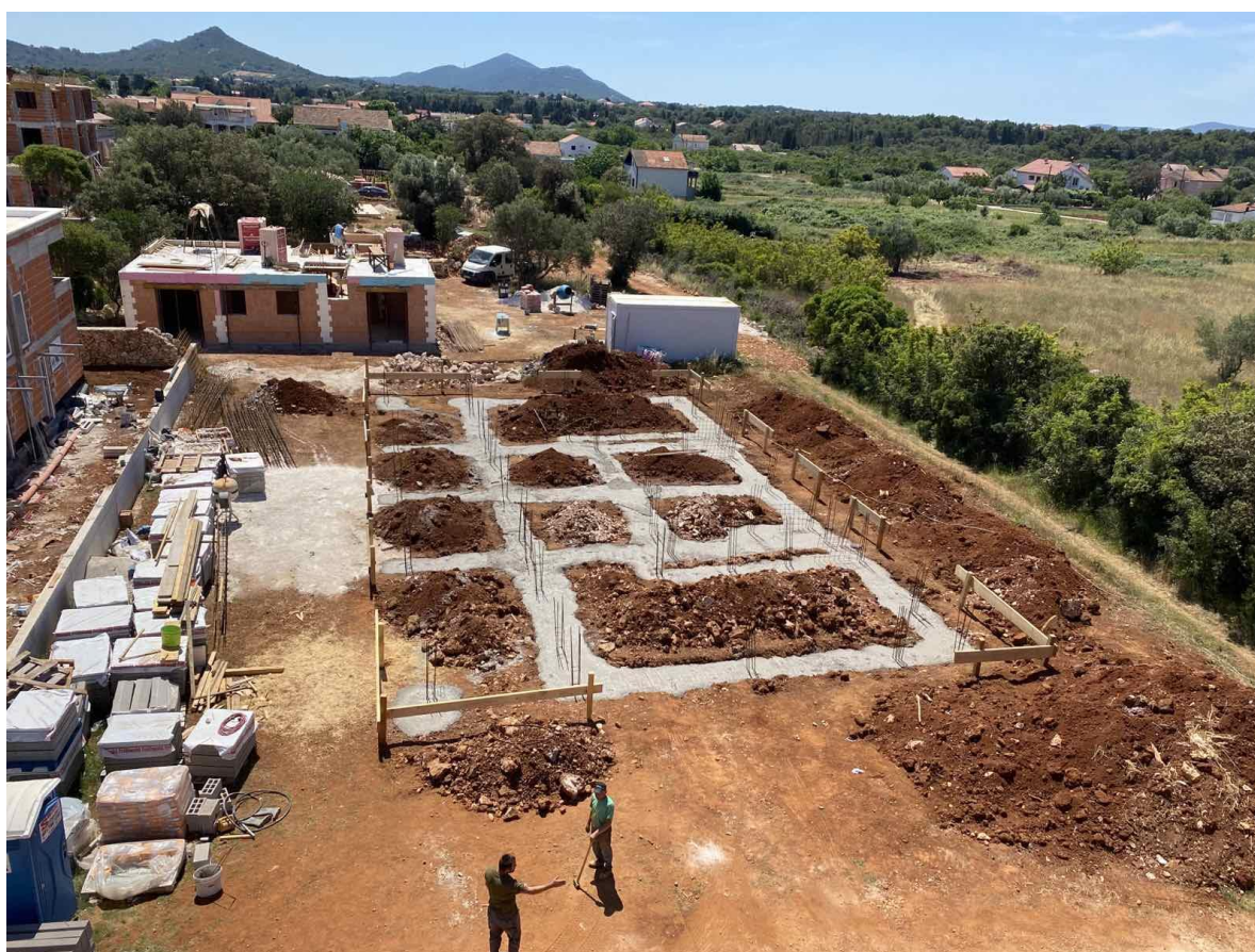
Slika 3.3.1. – Betonirani nadtemelj
