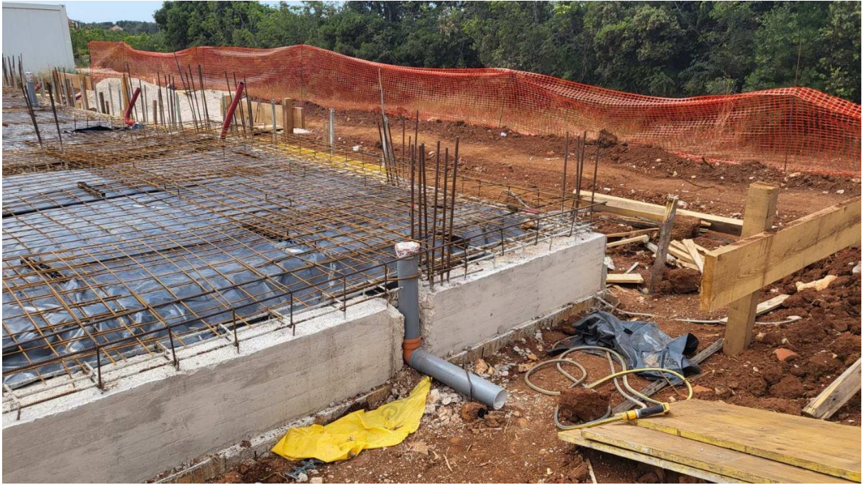
Slika 3.5.2. – Demontirana oplata (vidljiva lica betona)
