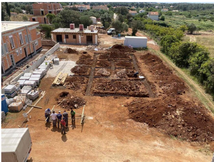
Slika 3.2.2. – Armatura nadtemeljnog zida
