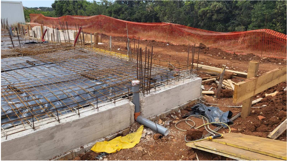
Slika 3.5.2. – Demontirana oplata (vidljiva lica betona)
