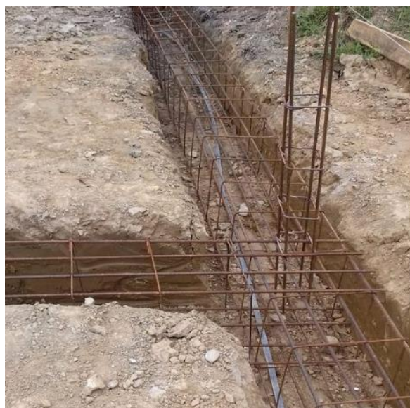
Slika 4.1. Armatura elastičnih temeljnih nosača na tlu
