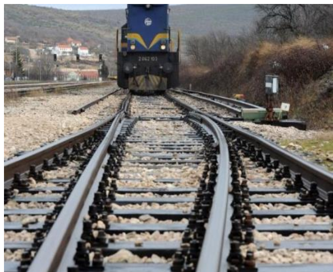
Slika 3.5. Željeznička pruga- nosač na elastičnoj podlozi,
