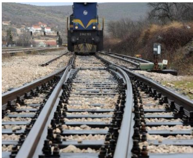
Slika 3.5. Željeznička pruga- nosač na elastičnoj podlozi,
