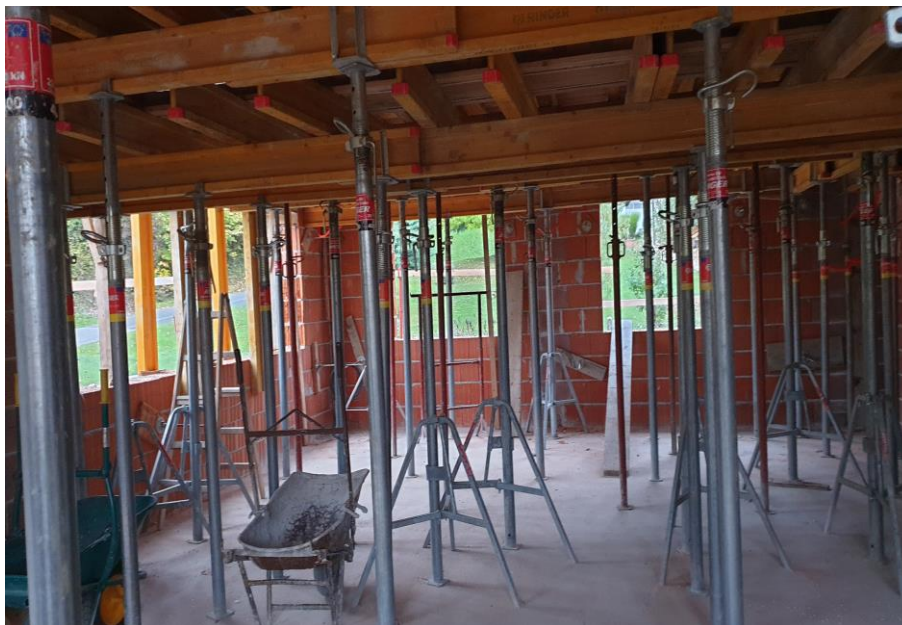
Slika 3.6.1 Oplata za AB ploču
