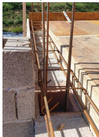
Slika. 3.3.2 Armatura za vertikalne i horizontalne serklaže
