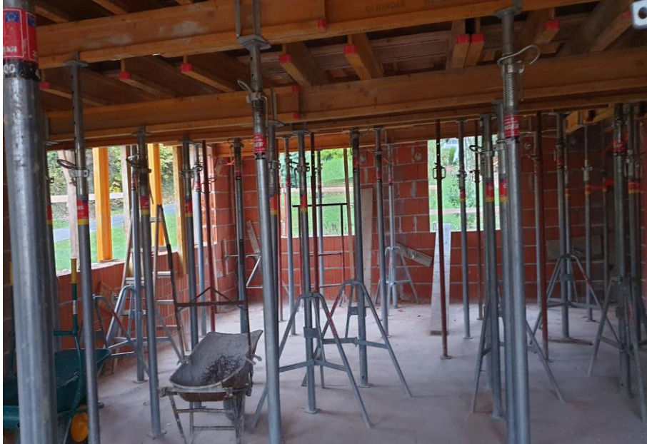
Slika 3.6.1 Oplata za AB ploču
