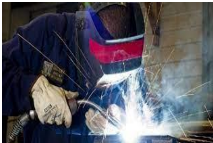
Slika 3.1 Zavarivanje sa maskom za zavarivanje i zaštitnom opremom[11]
