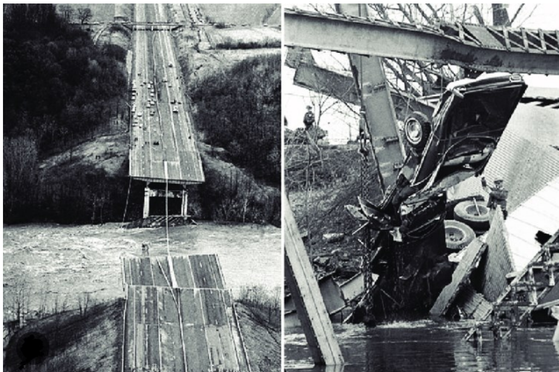
Slika 2.1. Srušeni most „Silver Brigde“ u Ohio-u [5]
