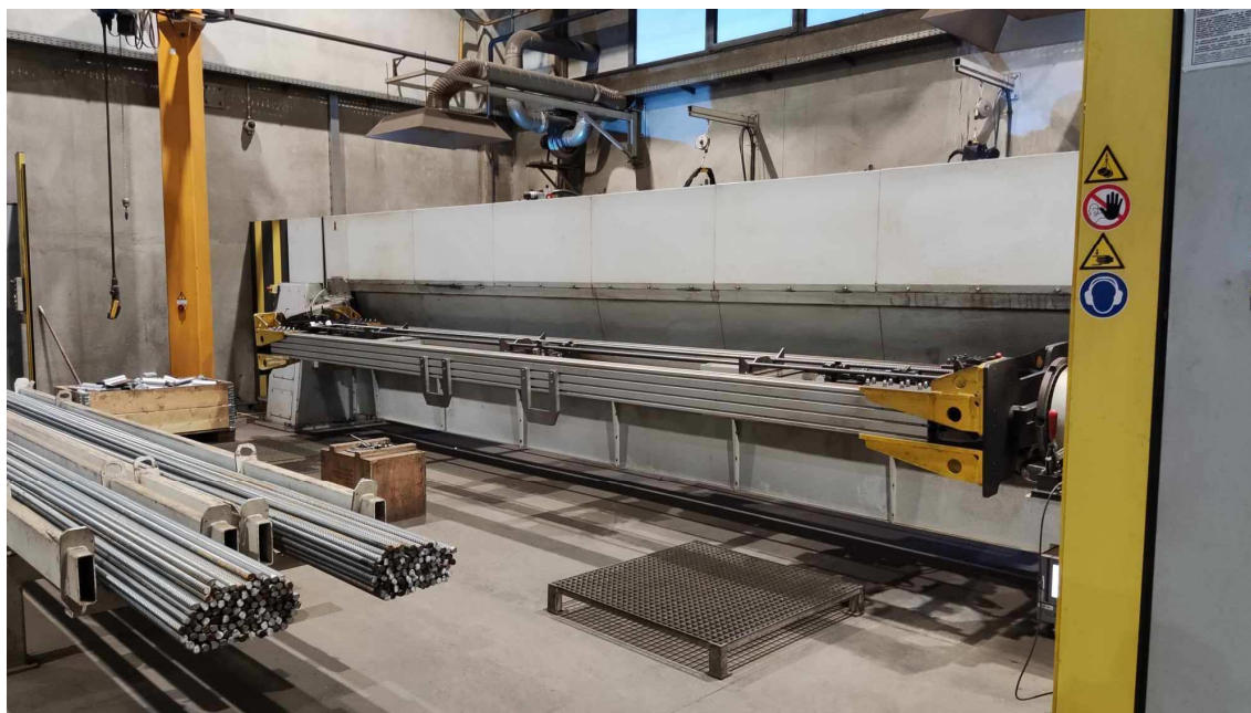
Slika 14. Prednja strana automatizirane linije
