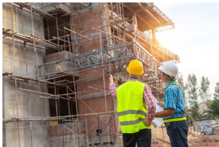
Slika 4. Nadzor na gradilištu (izvor: web)
