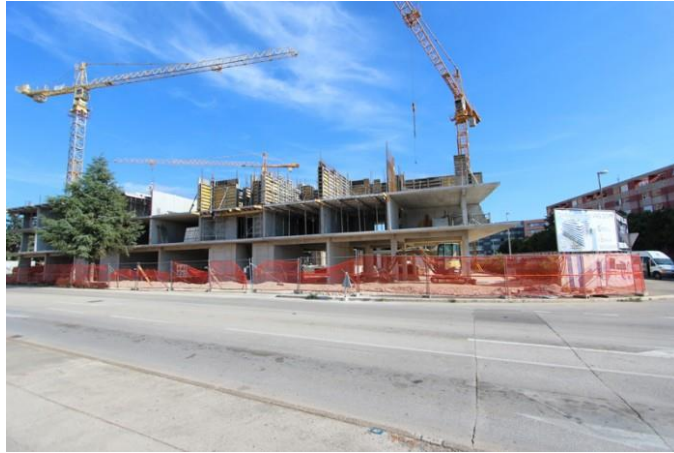
Slika 8. Gradilište ograđeno zaštitnom ogradom (izvor: web)
