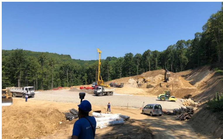
Slika 7. Deponij građevinskog materijala na gradilištu (izvor: web)
