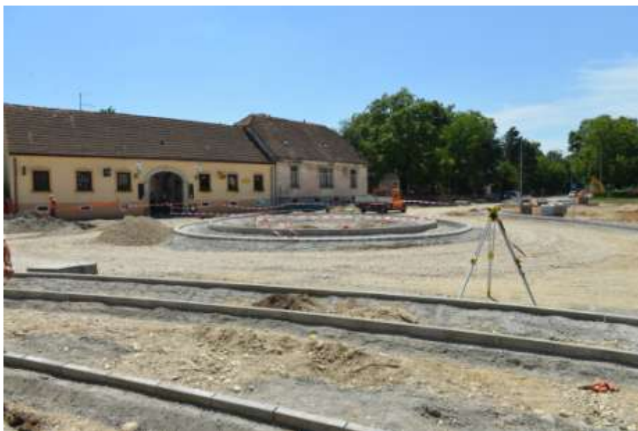
Slika 17. Postava betonskih rubnjaka u betonskoj podlozi (Izvor: PZC Varaždin d.d., arhiva fotografija, 2013.)
