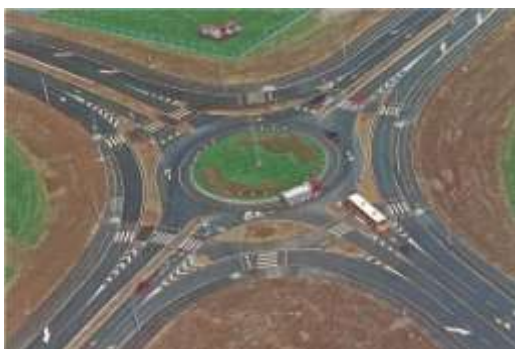
Slika 7. Izgled srednje velikoga kružnog raskrižja (Varaždin, Gospodarska ulica)
