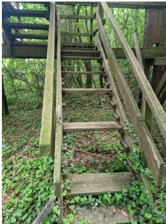
Slika 10.11. Dotrajali dijelovi vidikovca – ulazne stepenice
