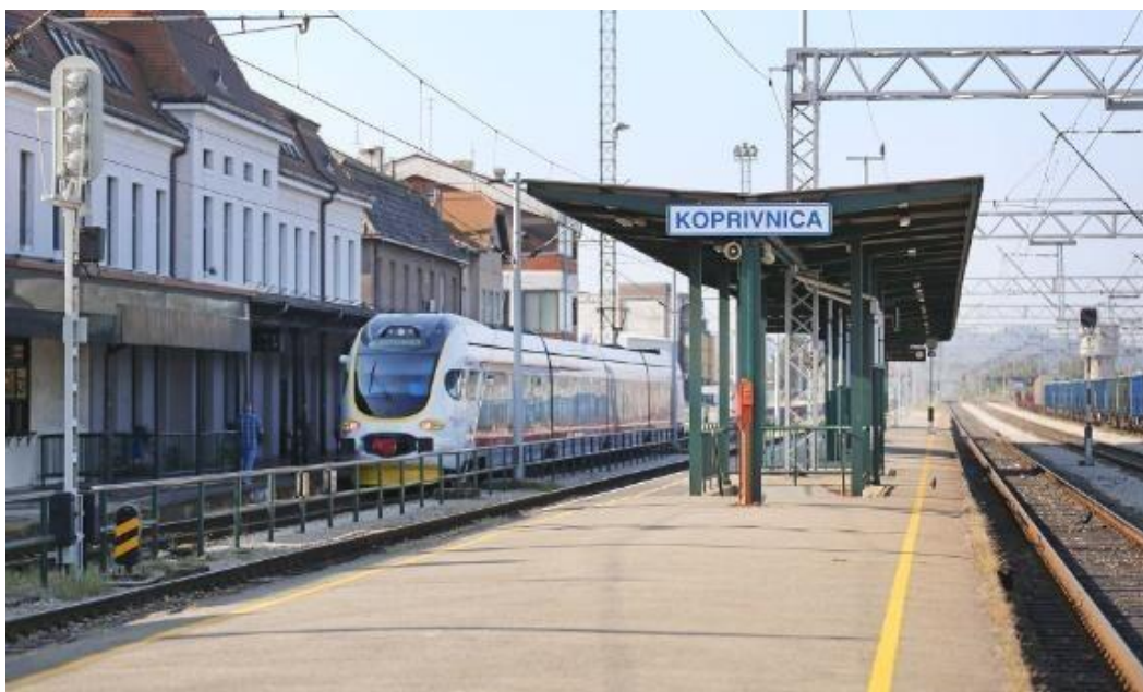
Slika 64 Željeznički kolodvor u gradu Koprivnici
