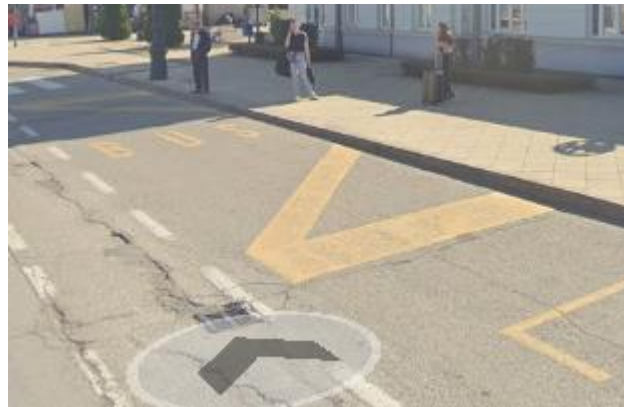
Slika 53 Autobusno stajalište u Varaždinu kod željezničkog kolodvora
