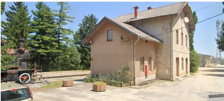
Slika 49 Željeznički kolodvor u gradu Ivancu
