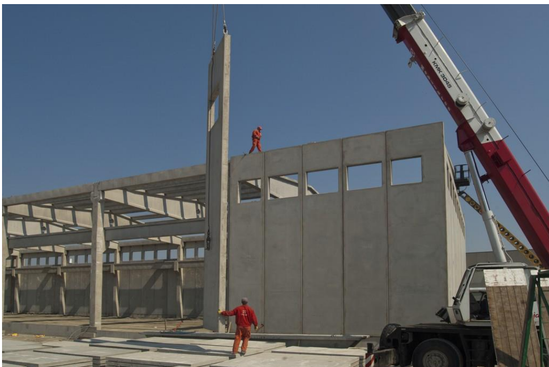
Slika 1.7. Montaža predgotovljenih panela
