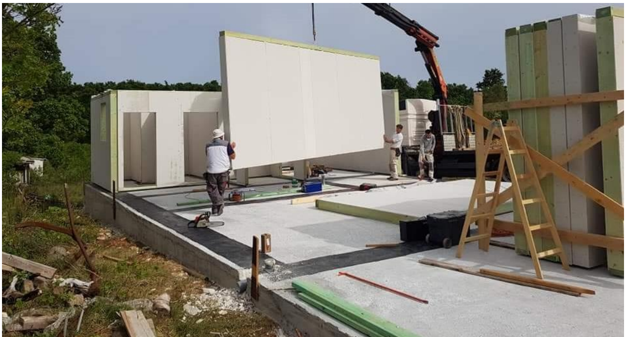
Slika 1. Gradnja montažne kuće
