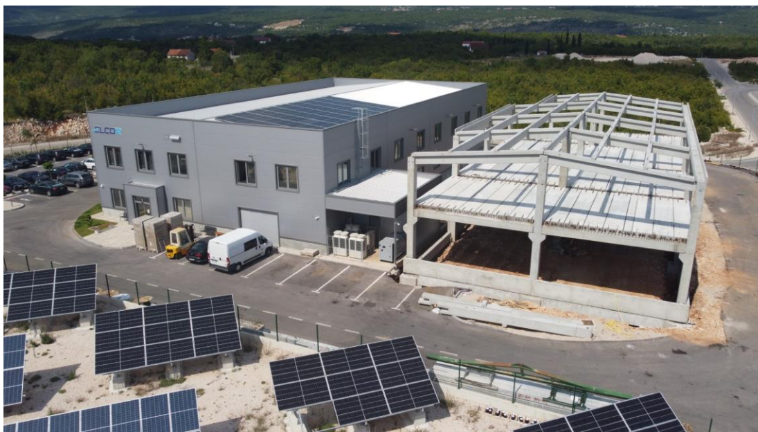
Slika 4. Montirana AB konstrukcija
