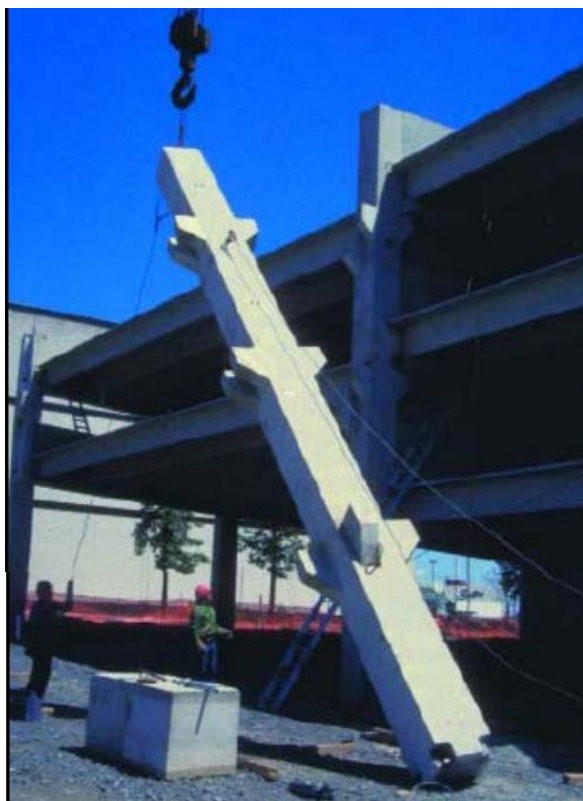
Slika 1.1. Predgotovljeni AB stup
