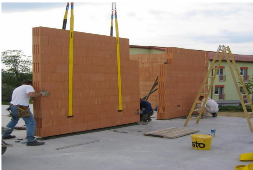
Slika 7.3. Montaža predgotovljenog zidnog opečnog elementa
