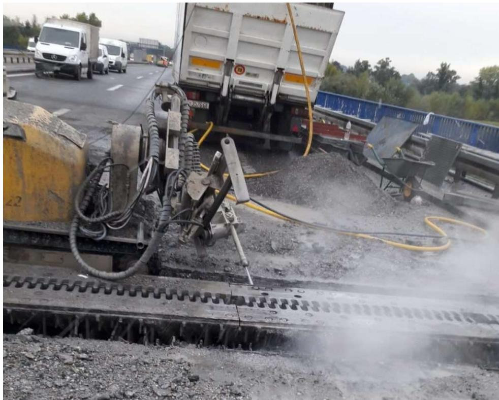
*Slika 18: Hidrorazaranje betonske konstrukcije*
