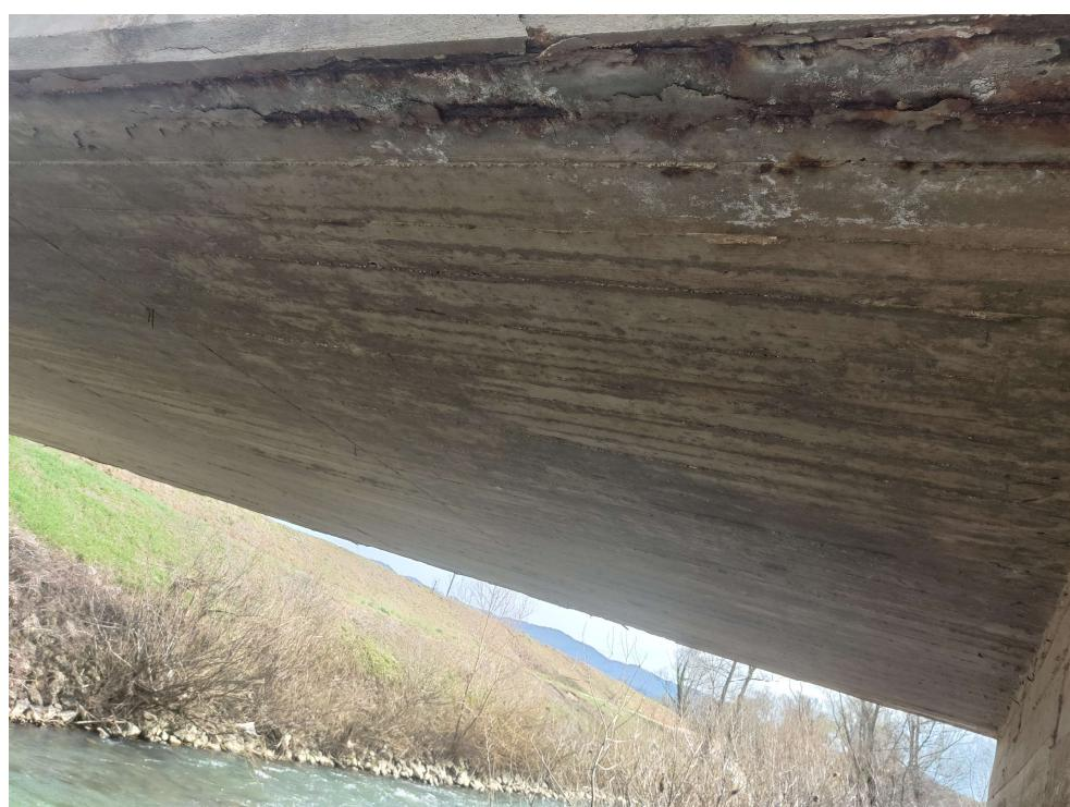
*Slika 26: Ljuštenje betona s donje strane ploče
