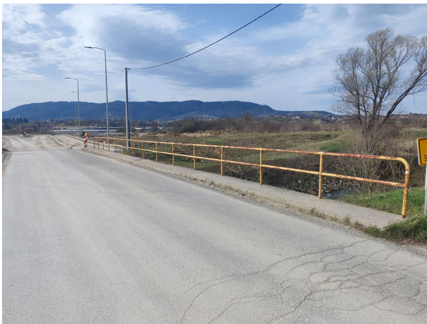
Slika 21: Oštećenje kolničkog zastora (autorski rad)
