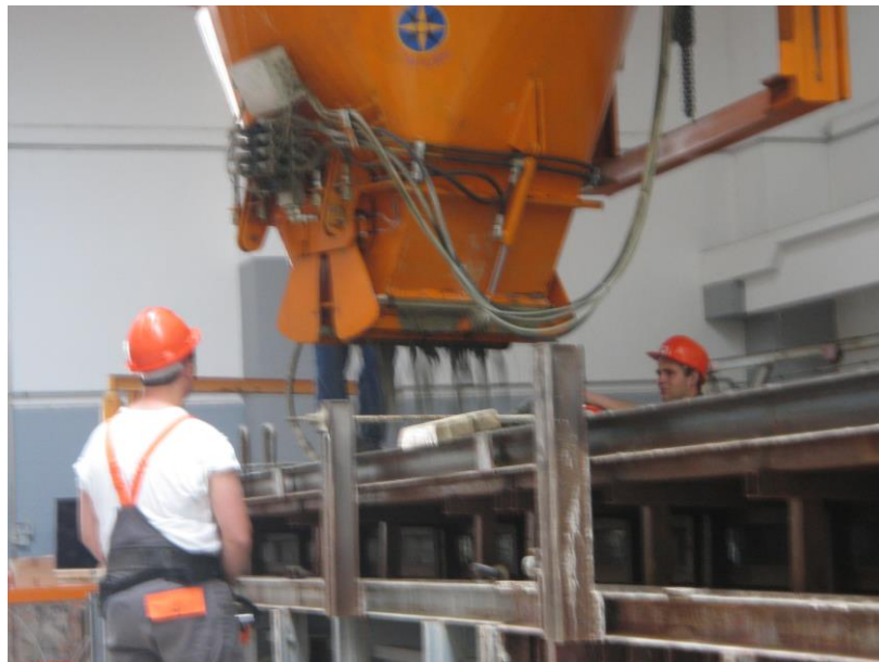
Slika 4.2 Betoniranje prednapete grede
