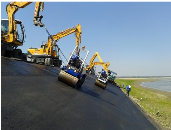
Slika 54. Zbijanje asfaltne mješavine vodoneprop. asfaltnog sloja (donja zona)
