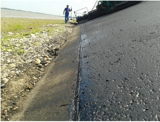
Slika 48. Uzdužni spoj na dnu zahvata kvalitetno premazan hladnom bitumenskom pastom
