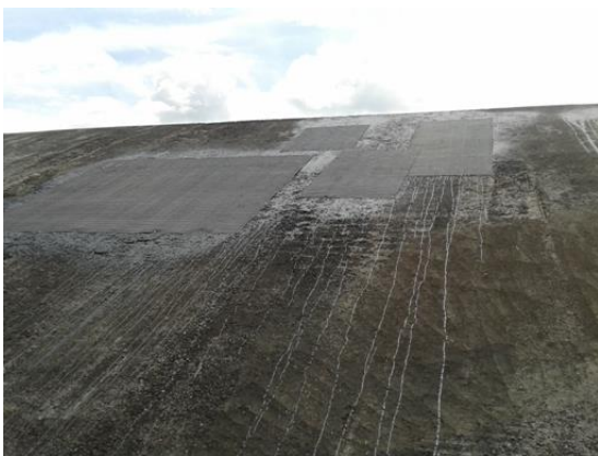
Slika 38. Ugrađene mreže za armiranje asfalta na mjestima saniranih površina plošnih oštećenja
