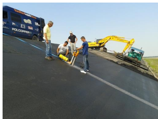
Slika 59. Uzorkovanje uzoraka iz ugrađenog asfaltnog sloja bušenjem
