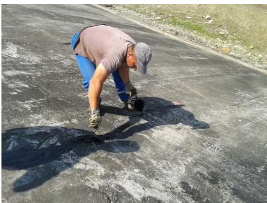
Slika 40. Zapunjavanje strukturnih pukotina vrućom polimernom bitumenskom masom
