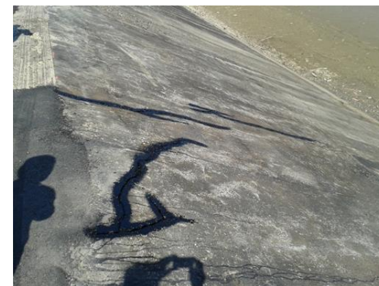
Slika 41. Sanirane strukturne pukotine
