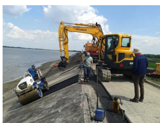
Slika 35. Zbijanje asfalta na mjestima plošnih oštećenja
