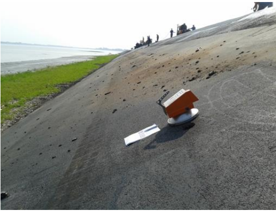
Slika 66. Mjerenje zbijenosti ugrađenog vodoneprop. asfaltnog sloja neraznom metodom
