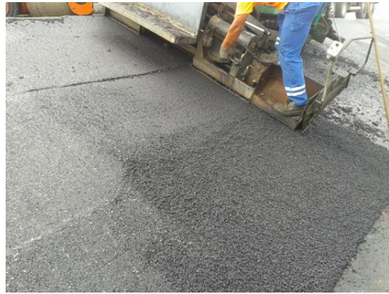
Slika 73. Detalj ručne ugradnje (gornja zona je mjestimično šira od pegle finišera)
