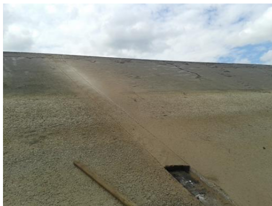
Slika 21. Zarezivanje poprečnog „šlica“
