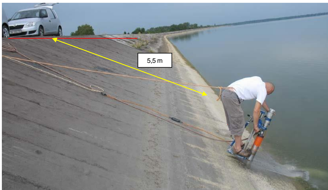
Slika 84. Bušenje uzoraka \varnothing 100 mm na asfalt-betonskoj oblozi nasipa
