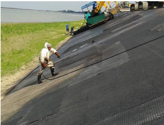
Slika 44. Špricanje polimerne bitumenske kationske emulzije na pripremljenu podlogu
