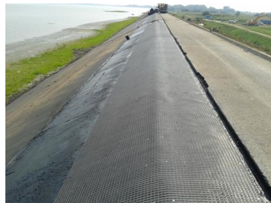
Slika 71. Detalj postavljene mreže za armiranje asfalta na spoju kosine i krune nasipa (š=2m)
