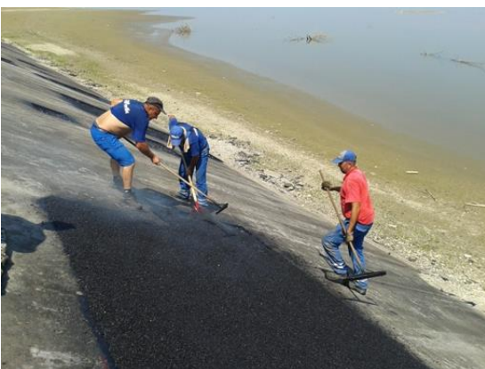
Slika 34. Ručno razastiranje i planiranje asfaltne mješavine na mjestima plošnih oštećenja
