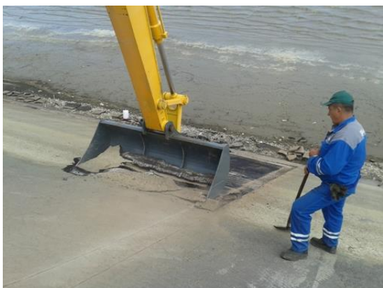
Slika 22. Uklanjanje oštećene asfalt-betonske obloge struganjem korpom bagera (donja zona)
