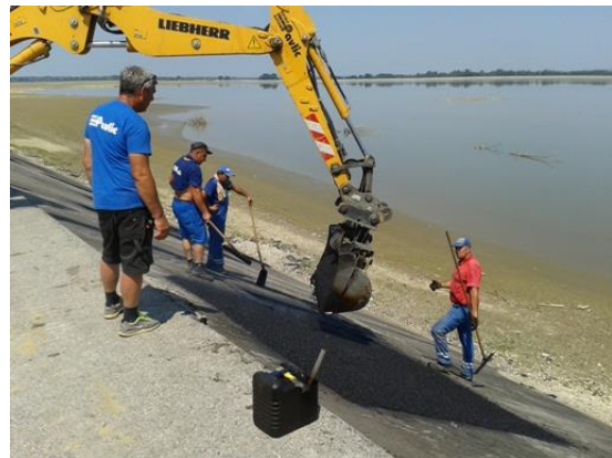
Slika 33. Ugradnja asfalta na mjestima plošnih oštećenja
