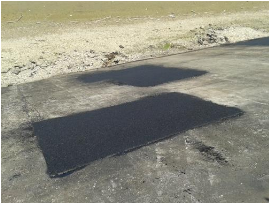
Slika 36. Sanirana površina na mjestima plošnih oštećenja
