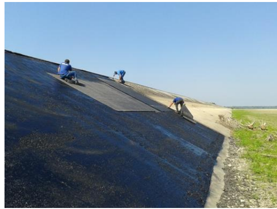
Slika 37. Ugradnja mreže za armiranje asfalta na mjestima saniranih površina plošnih oštećenja
