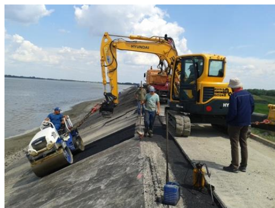
Slika 35. Zbijanje asfalta na mjestima plošnih oštećenja
