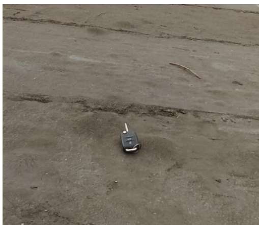
Slika 12. Oštećenja asfaltnog mastiksa
