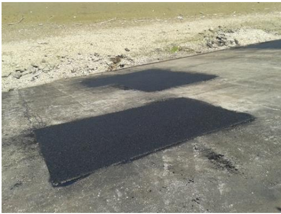
Slika 36. Sanirana površina na mjestima plošnih oštećenja
