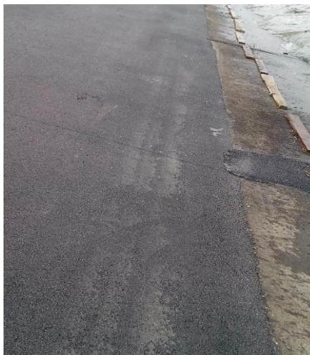
Slika 7. Vodozaštitni sloj asfalta
