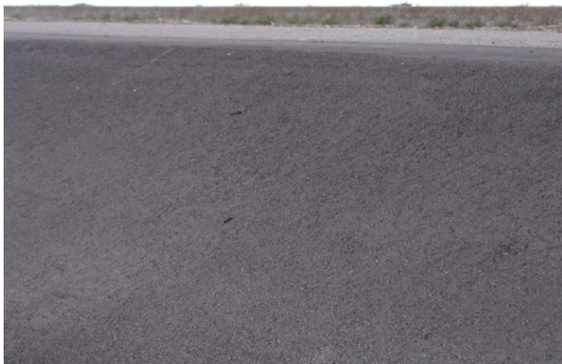
Slika 6. Vodozaštitni sloj asfalta
