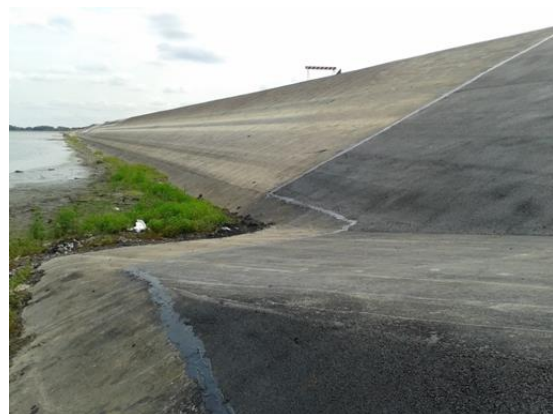
Slika 65. Premazani svi radni spojevi na dijelu ulazno - silazne rampe
