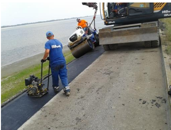
Slika 74. Zbijanje asfaltne mješavine vodoneprop. asfaltnog sloja na kosini i kruni nasipa
