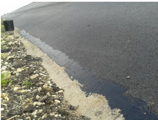
Slika 76. Kvalitetno premazan uzdužni sloj na dnu granice zahvata
