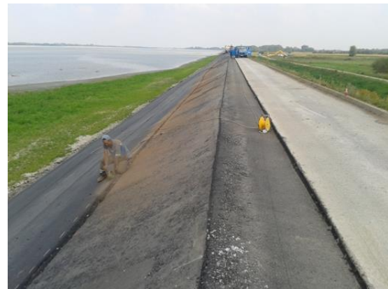
Slika 69. Zarezivanje uzdužnog spoja (spoj donje i gornje zone obloge nasipa)
