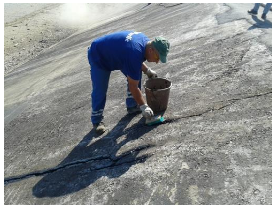
Slika 39. Nanašanje „primera“ na mjestima strukturnih pukotina
