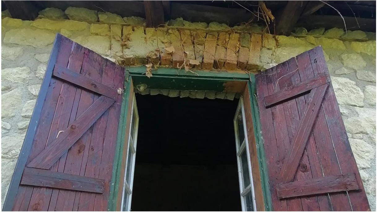
Slika 5.59: Izgled nadvoja prije restauracije
