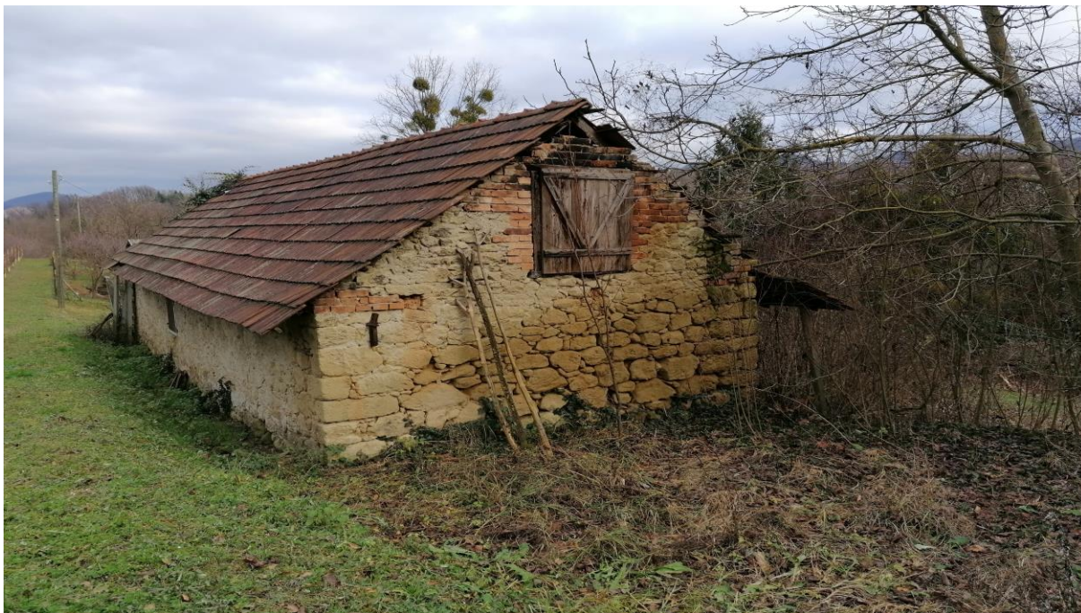
Slika 3.8: Zatečeno stanje – sjeverozapadno pročelje
