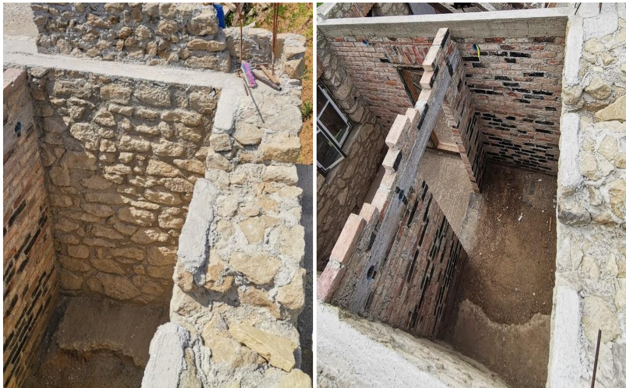
Slika 5.47: Nova ležišta grednika prije ugradnje novih grednika
