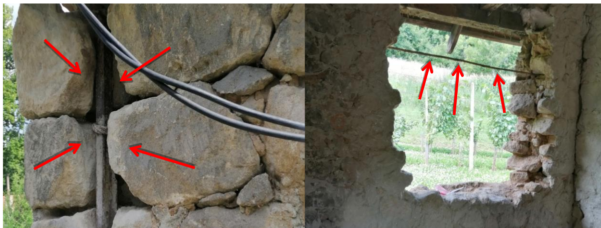
Slika 5.22: Čelični natezač (lijevo) i čelična sajla unutar zidova (desno)
