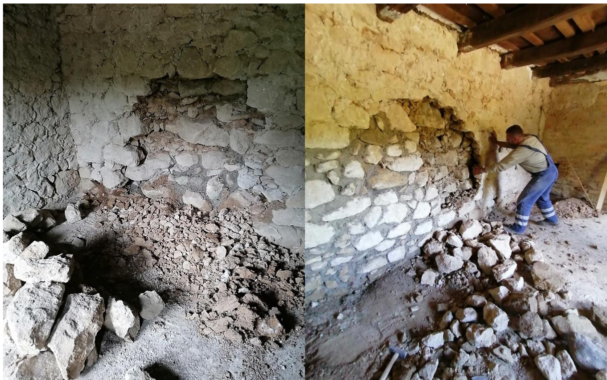
Slika 5.17: Rušenje i ponovno zidanje oštećenog zida
