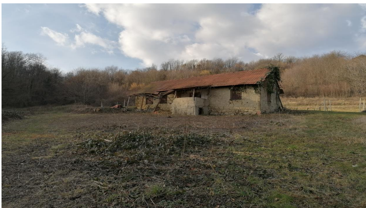
Slika 3.3: Zatečeno stanje – jugoistočno pročelje nakon čišćenja raslinja
