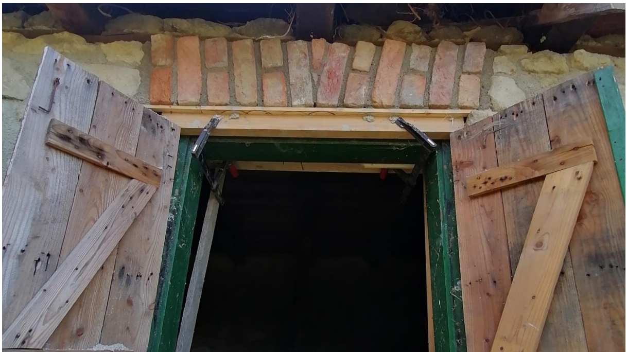
Slika 5.60: Izgled nadvoja nakon restauracije
