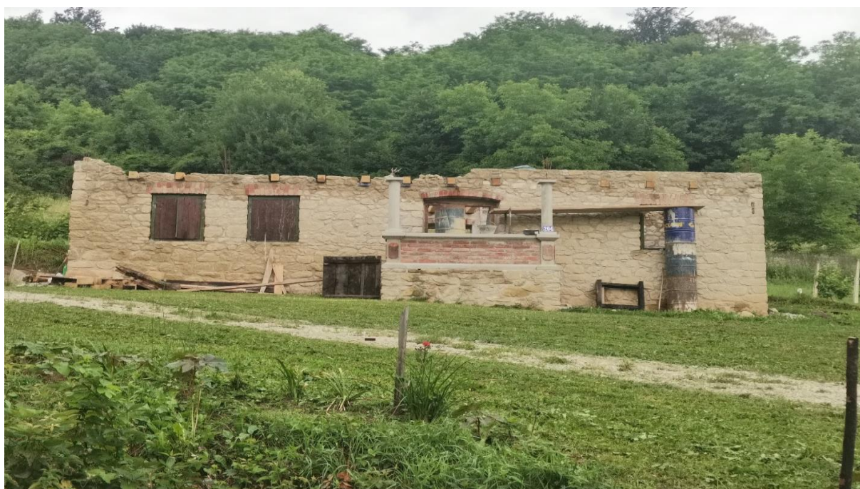
Slika 5.41: Izgled serklaža s pročelja
