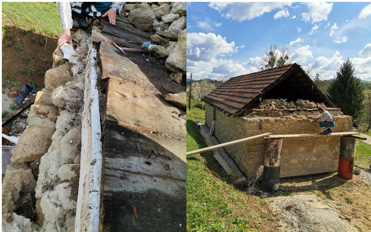
Slika 5.31: Uklanjanje grede u zabatnom zidu
