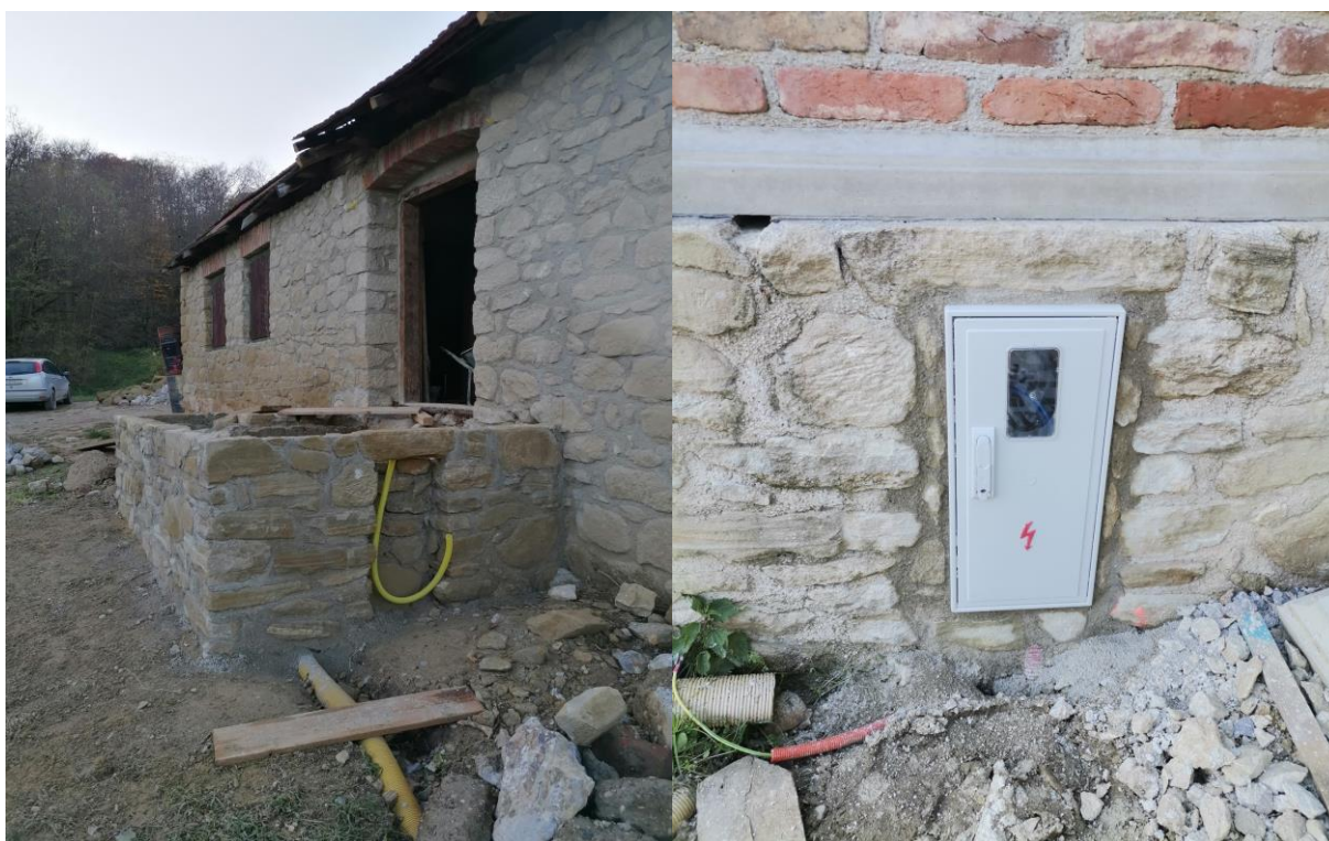
Slika 5.92: Ugradnja priključnog mjernog ormarića u nišu
