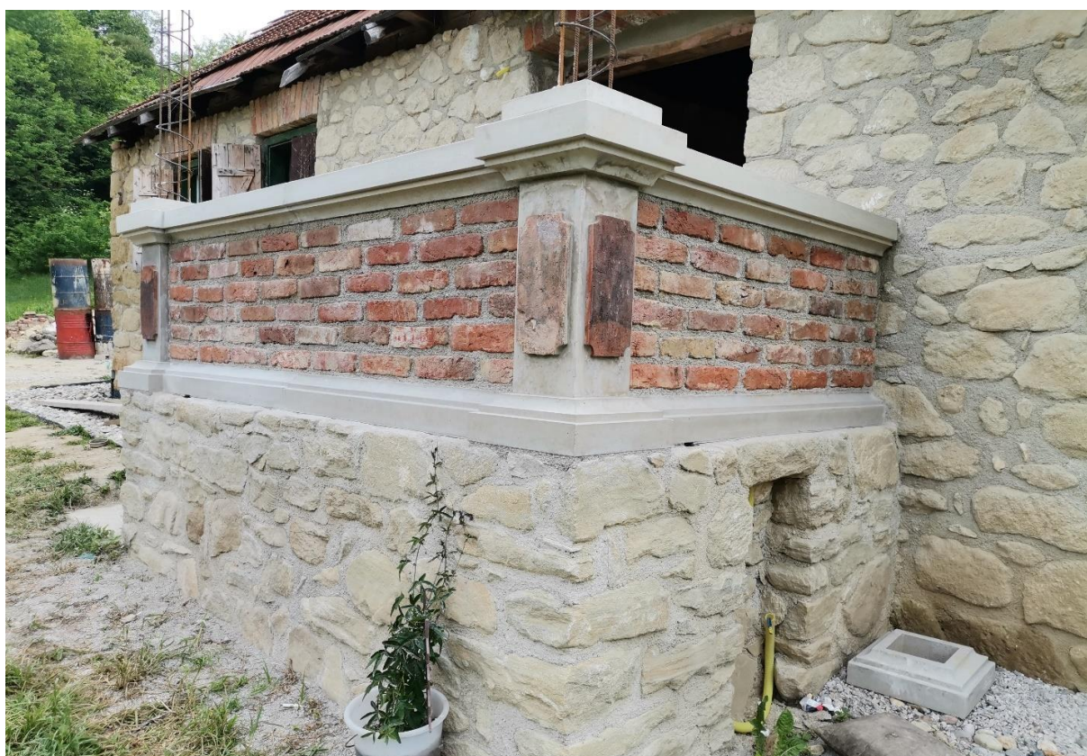
Slika 5.102: Izgled zidića od opeke na terasi
