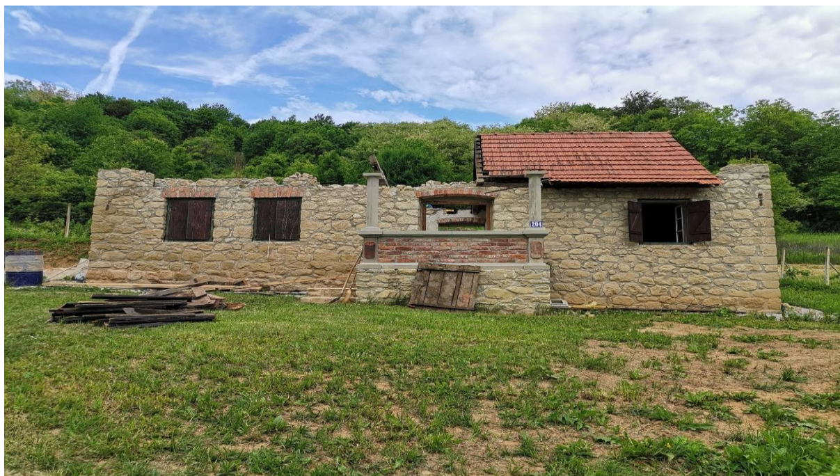
Slika 5.73: Segmentno rušenje krova
