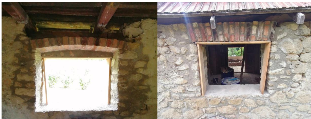
Slika 5.63: Izrada novog nadvoja
