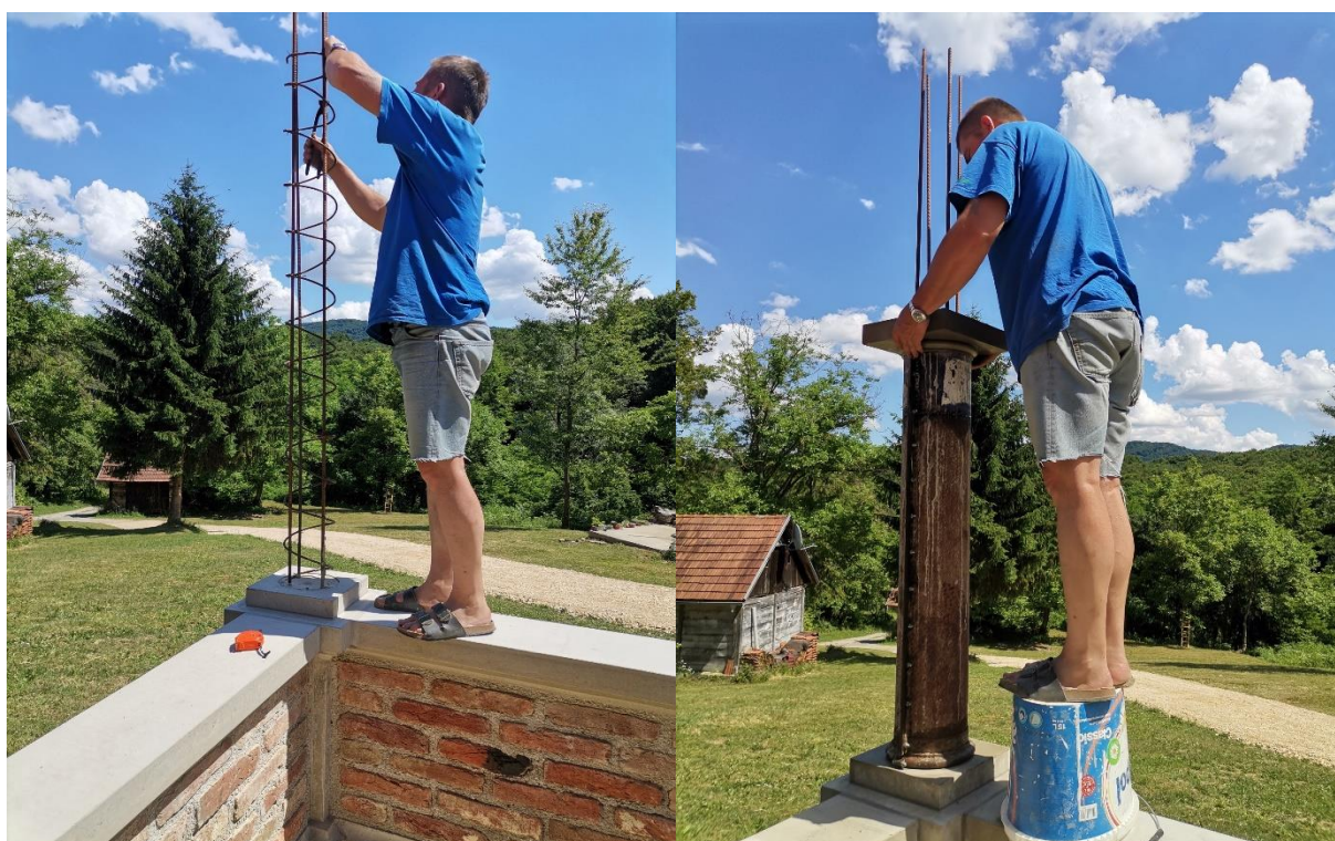
Slika 5.100: Izrada betonskog stupa – ugradnja armature i kalupa
