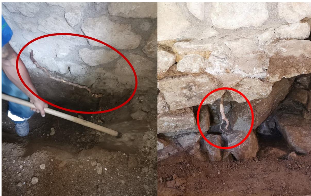
Slika 3.21: Prikaz korijenja prilikom iskopa s unutarnje strane objekta
