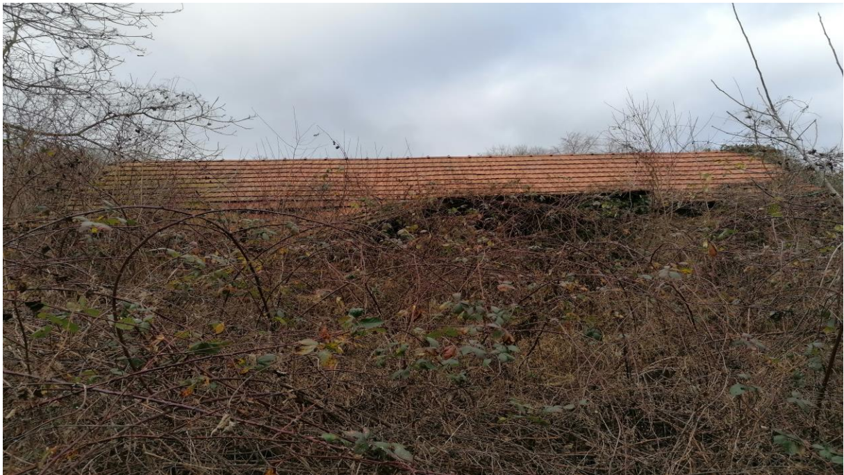
Slika 3.4: Zatečeno stanje – jugoistočno pročelje (bliži kadar)
