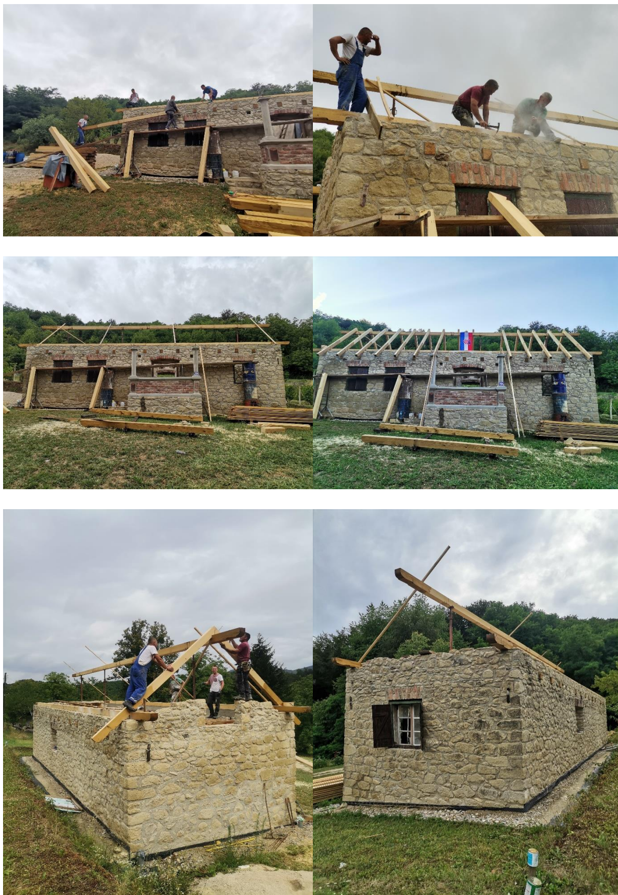
Slika 5.83: Postavljanje nazidnih greda, sljemene grede i rogova
