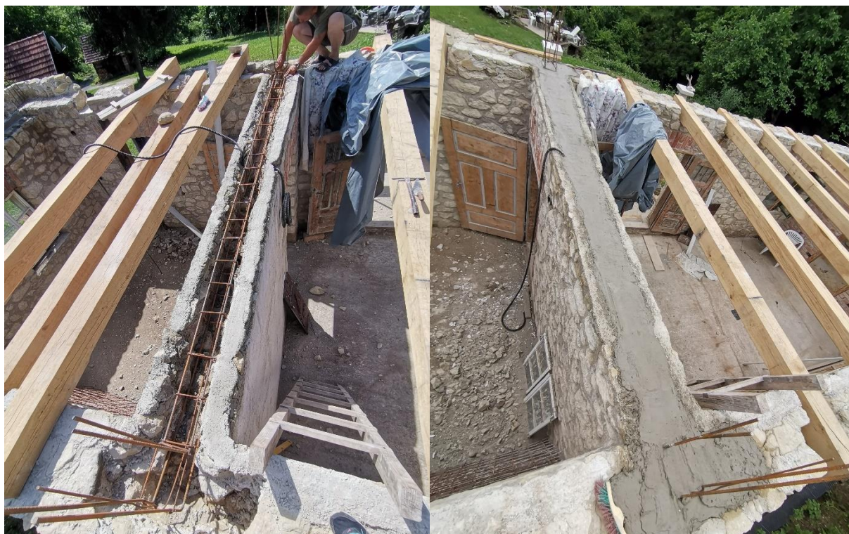
Slika 5.36: Ugradnja armature i betona u kamenu kanalicu (pregradni zid)
