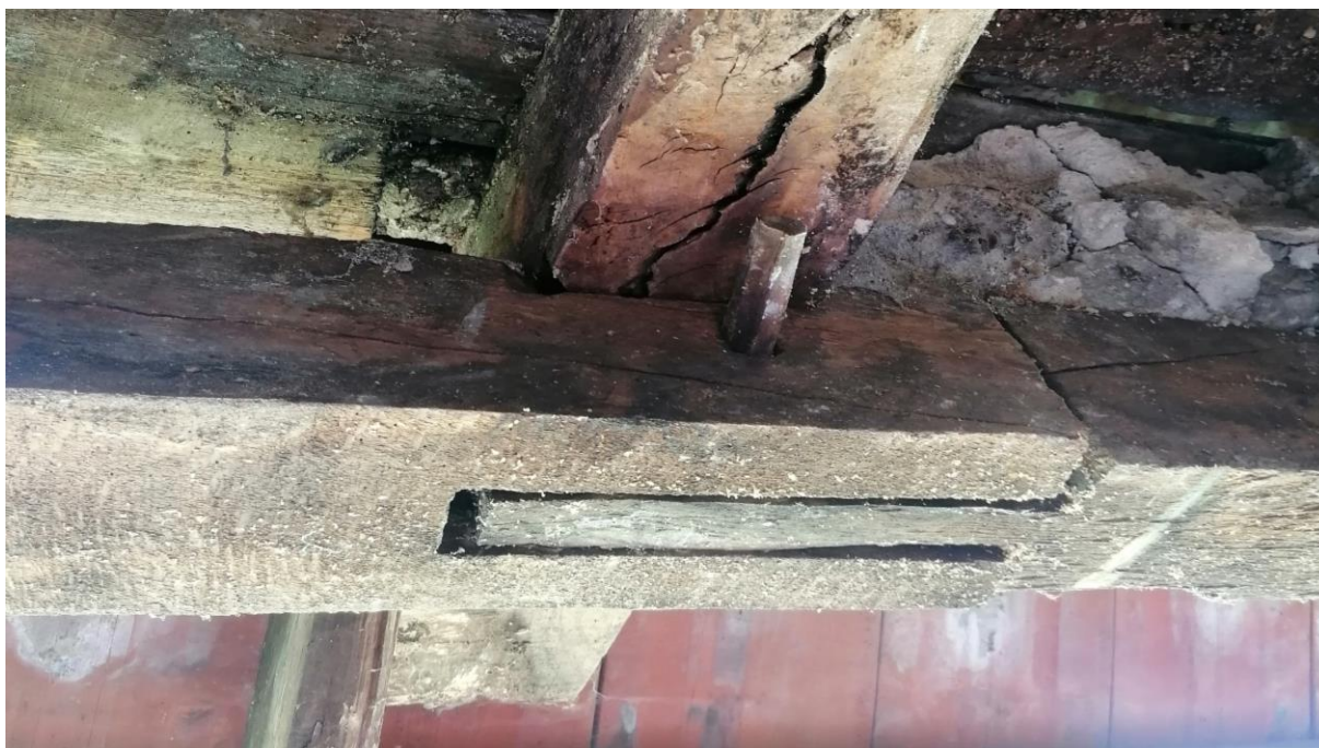
Slika 3.35: Način spajanja nazidnih greda
