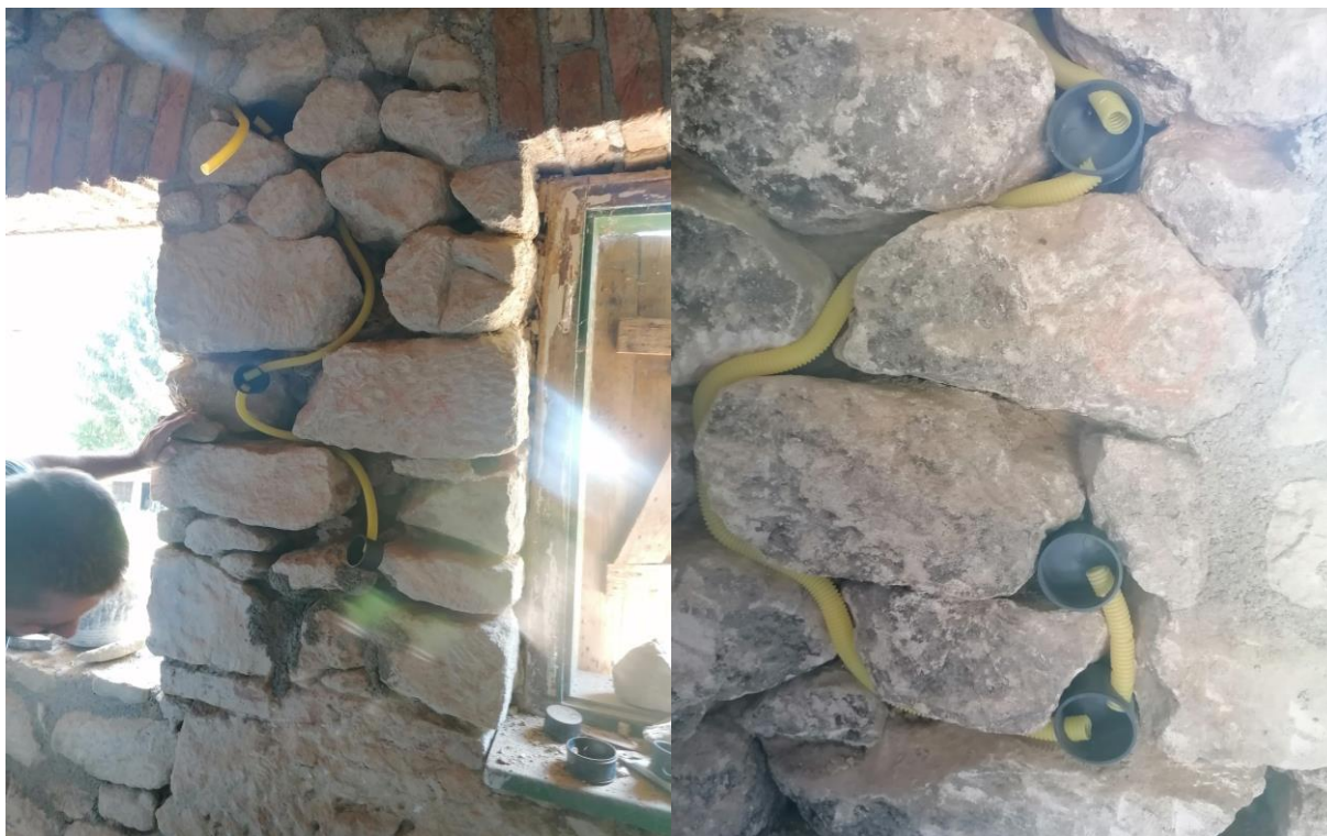
Slika 5.91: Postavljanje božira za struju
