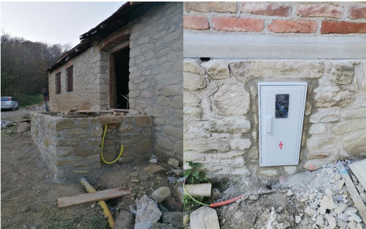
Slika 5.92: Ugradnja priključnog mjernog ormarića u nišu
