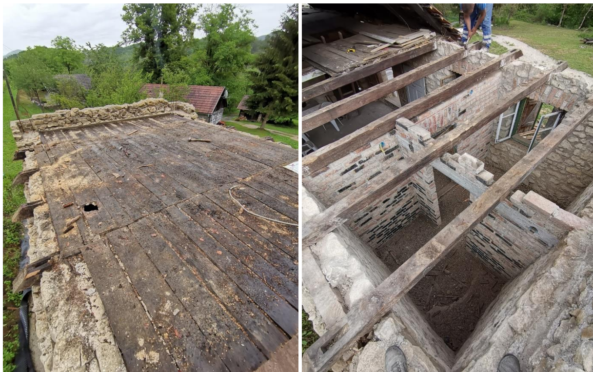
Slika 5.45: Izgled stropa i grednika prilikom demontaže
