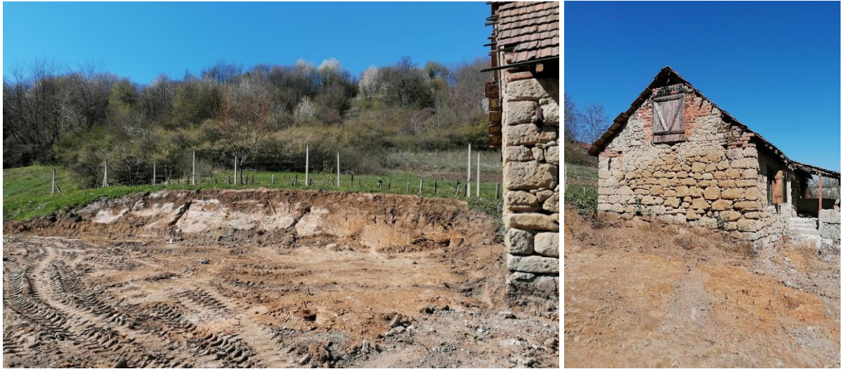
Slika 3.11: Prikaz iskopa pomoću mehanizacije uz zapadni zid
