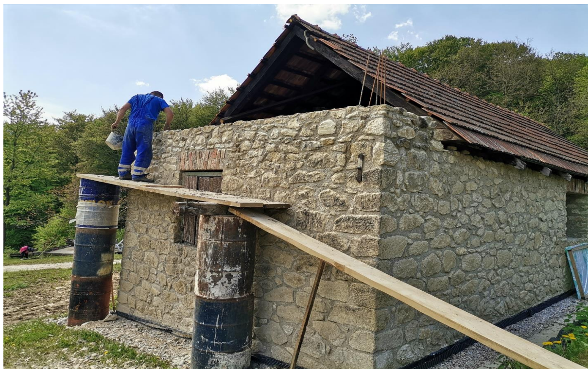
Slika 5.35: Ugradnja betona i improvizacija skele (istočna strana)
