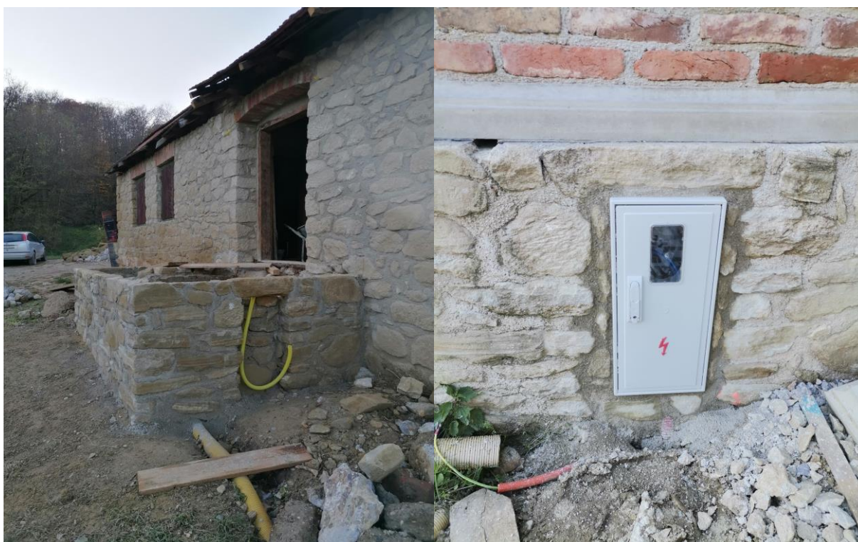
Slika 5.92: Ugradnja priključnog mjernog ormarića u nišu
