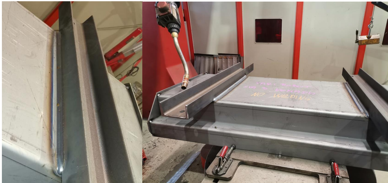
Slika 5.24. Dobiveni zavareni spojevi po dužini prijevoznog sloga [osobne slike]
