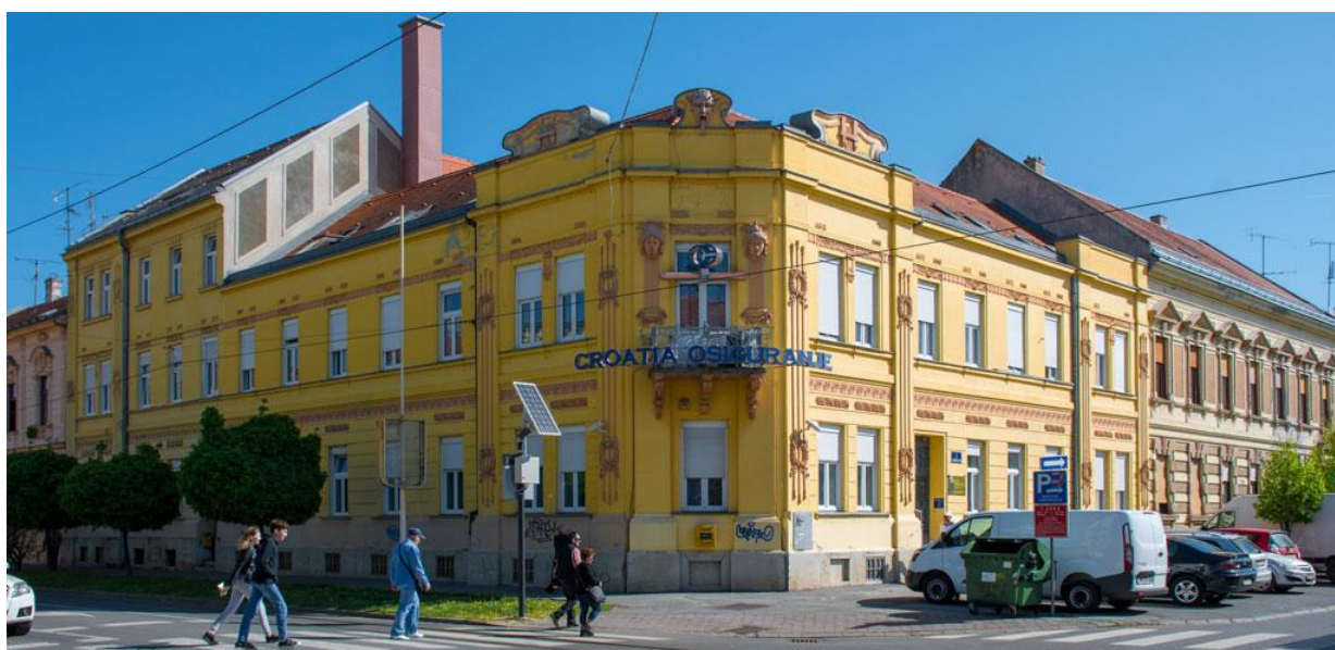
Slika 3-9 Kuća Bauer, Osijek
