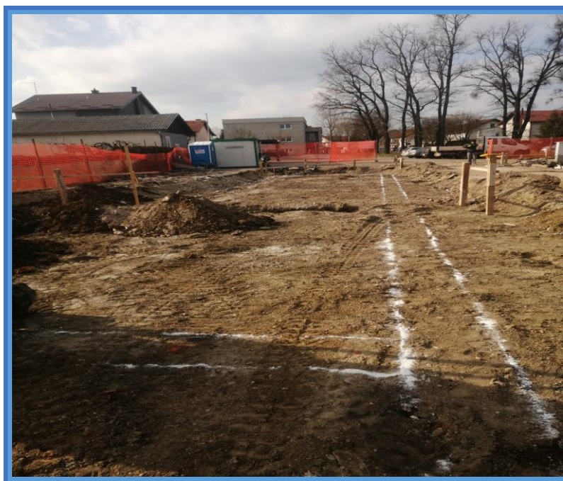
Slika 14. Iskop temeljnih traka-zgrada 2 [8].
