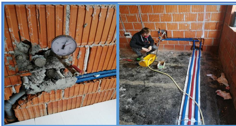
Slika 50. Tlačna proba cjevovoda [8].
