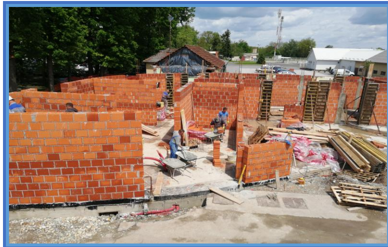
Slika 44. Zidanje nosivih zidova prizemlja – zgrada 1 [8].
