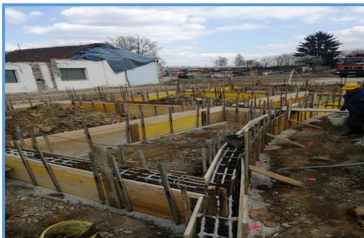
Slika 23. Betoniranje nadtemeljnih serklaža – zgrada 1 [8].
