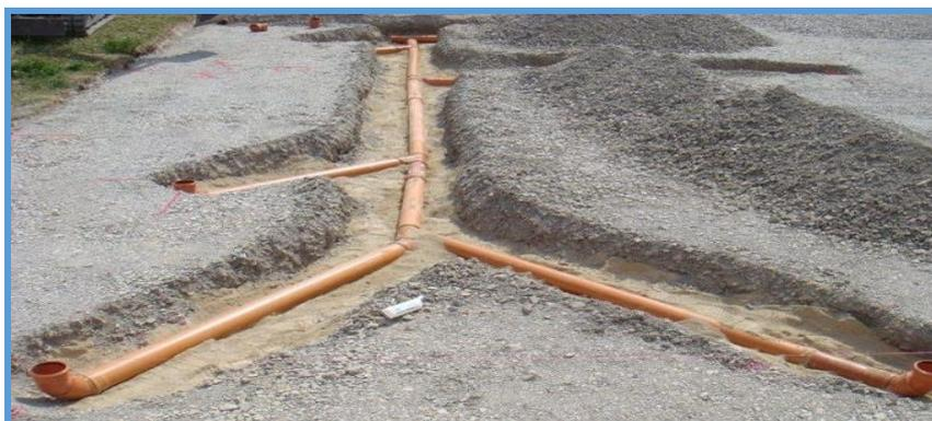
Slika 52. Postava kanalizacijskih cijevi [8].
