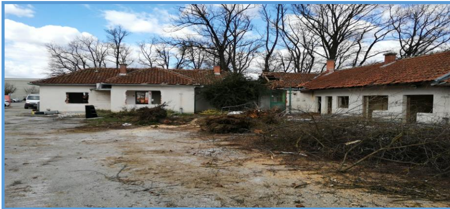
Slika 8. Rušenje postojećih zgrada na parceli [8].
