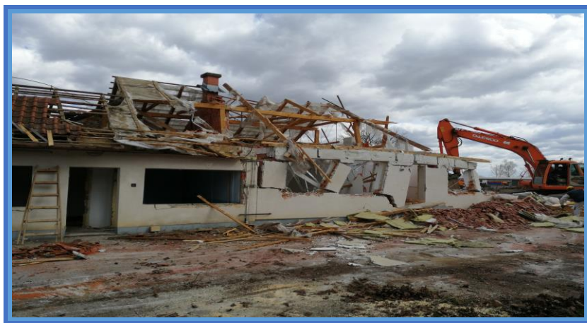
Slika 7. Rušenje postojećih zgrada na parceli [8].
