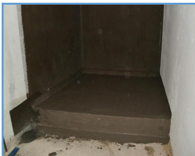
Slika 38. dvokomponentna polimercementna hidroizolacija [8].
