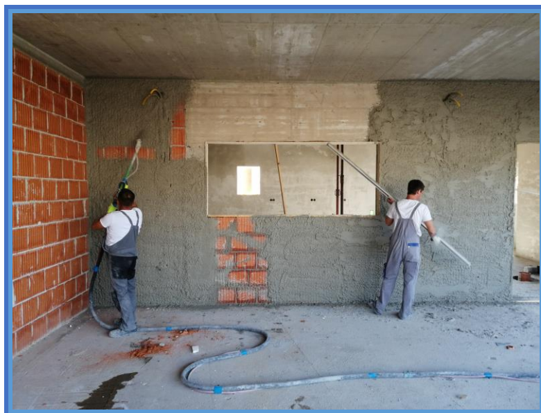
Slika 45. Strojno žbukanje zidova – zgrada 1 [8].
