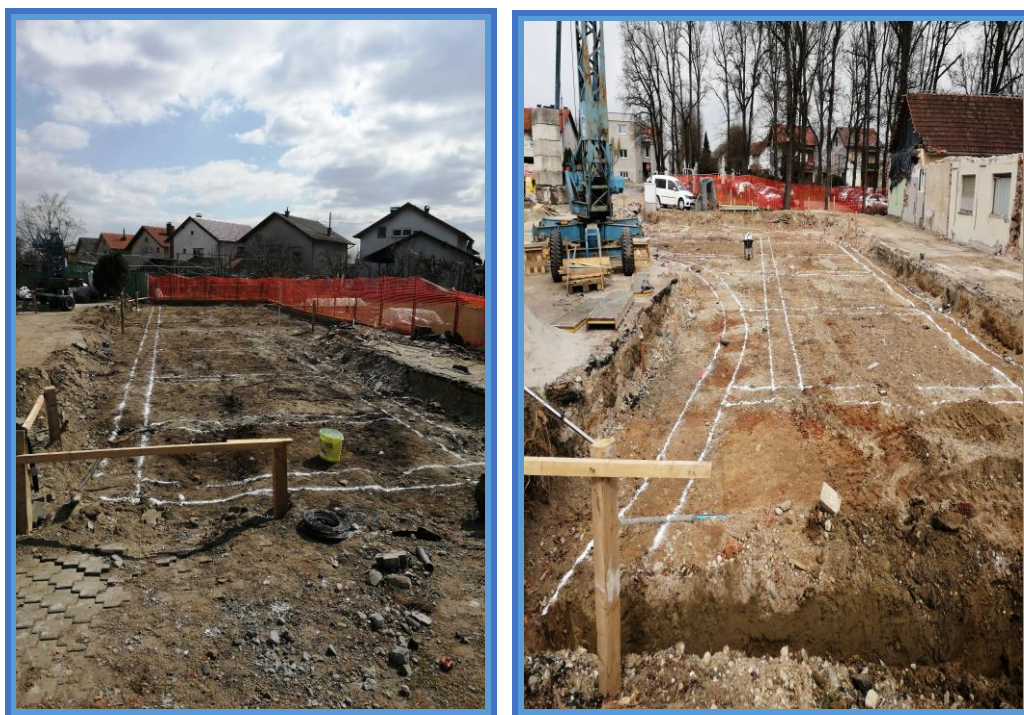
Slika 11. i 12. Zacrtavanje temeljnih traka [8].
