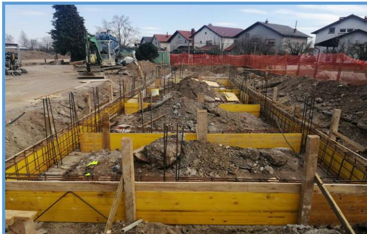
Slika 22. Betoniranje nadtemeljnih serklaža – zgrada 2 [8].
