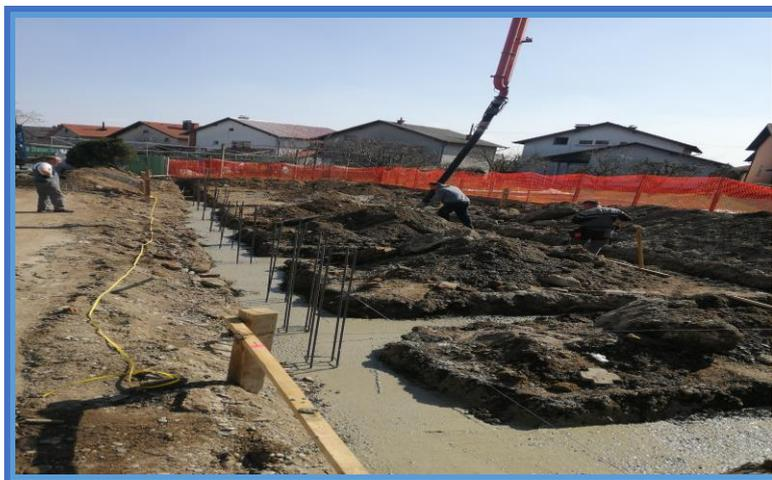
Slika 20. Betoniranje temeljnih traka – zgrada 2 [8].
