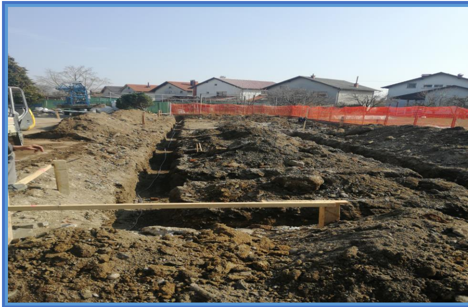
Slika 15. Iskop temeljnih traka-zgrada 2 [8].
