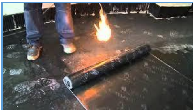
Slika 37. varenje ljepenke V4 [8].
