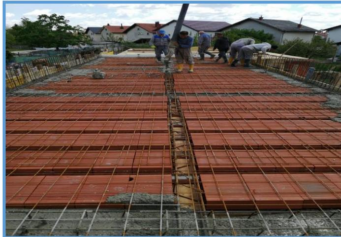
Slika 28. Armiranje i betoniranje fert stropa – zgrada 2 [2].
