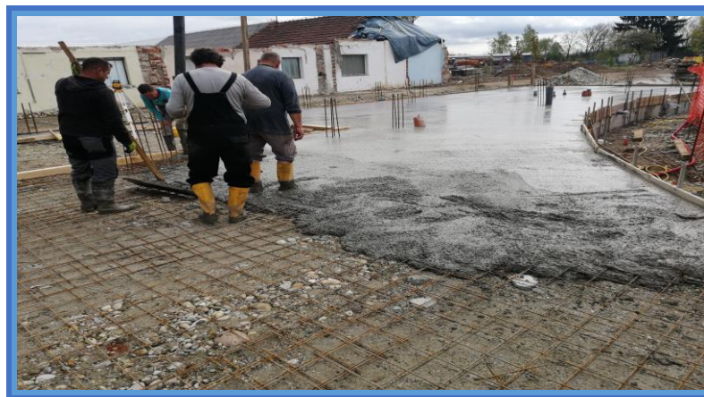
Slika 25. Betoniranje podne ploče prizemlja – zgrada 1 [8]
