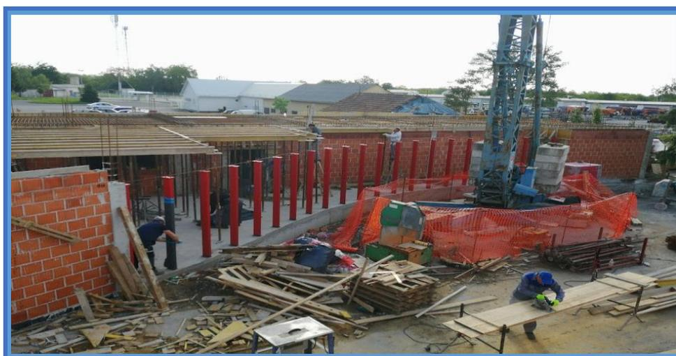
Slika 47. Postavljanje čeličnih stupova nosača fiksne ostakljene stijene [8].
