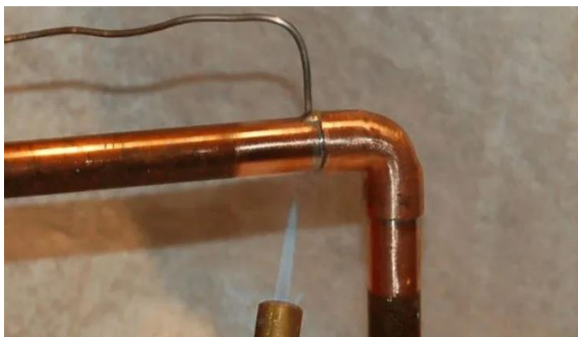
Slika 6.4. Tvrdo lemljenje koljenastog spoja
