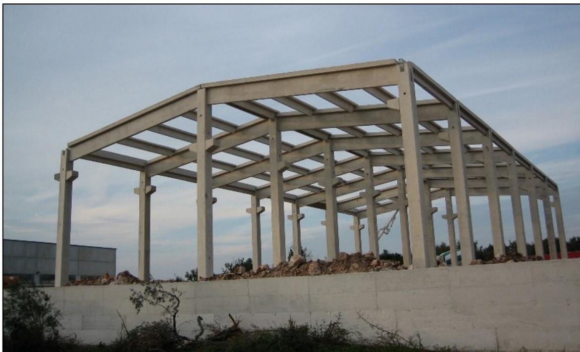
Slika 16: Montažna betonska nosiva konstrukcija industrijske hale (izvor: http://betoncomerce.hr/portfolio-view/montazne-hale/ )
