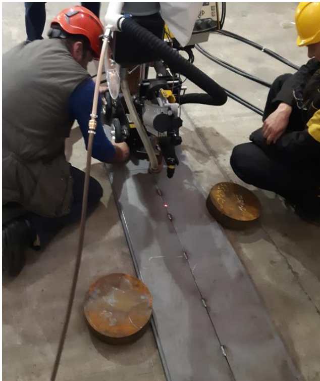
Slika 5.5.: Postavljanje automata za zavarivanje [34]
