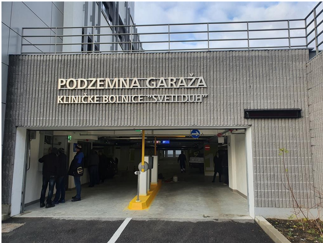
Slika 3. Podzemna garaža Kliničke bolnice „Sveti Duh“
