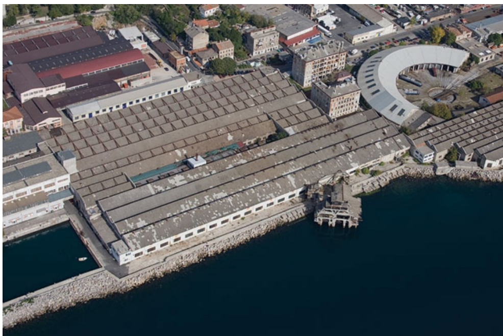
Slika 9. Zračni pogled na kompleks tvornice Torpedo ( https://inspiracija.eu/rijeka/ ; pristupljeno 26.08.2023.)
