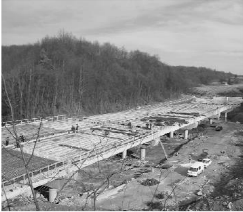
Sl.2.3.2. Priprema za betoniranje ploče [12]
