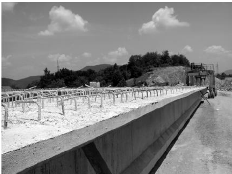
Sl.2.2.1. Proizvodnja predgotovljenih elemenata na gradilištu [12]
