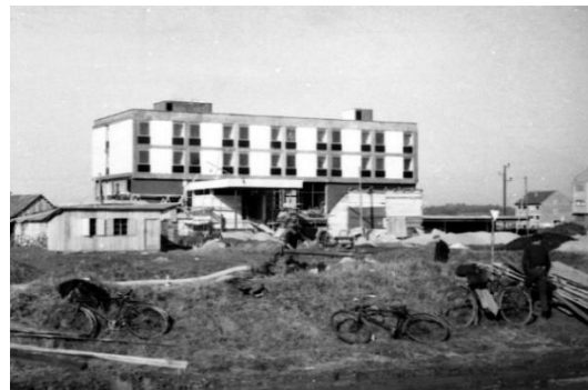
Fotografija 2. Hotel „Park“ u visokoj fazi izgradnje
