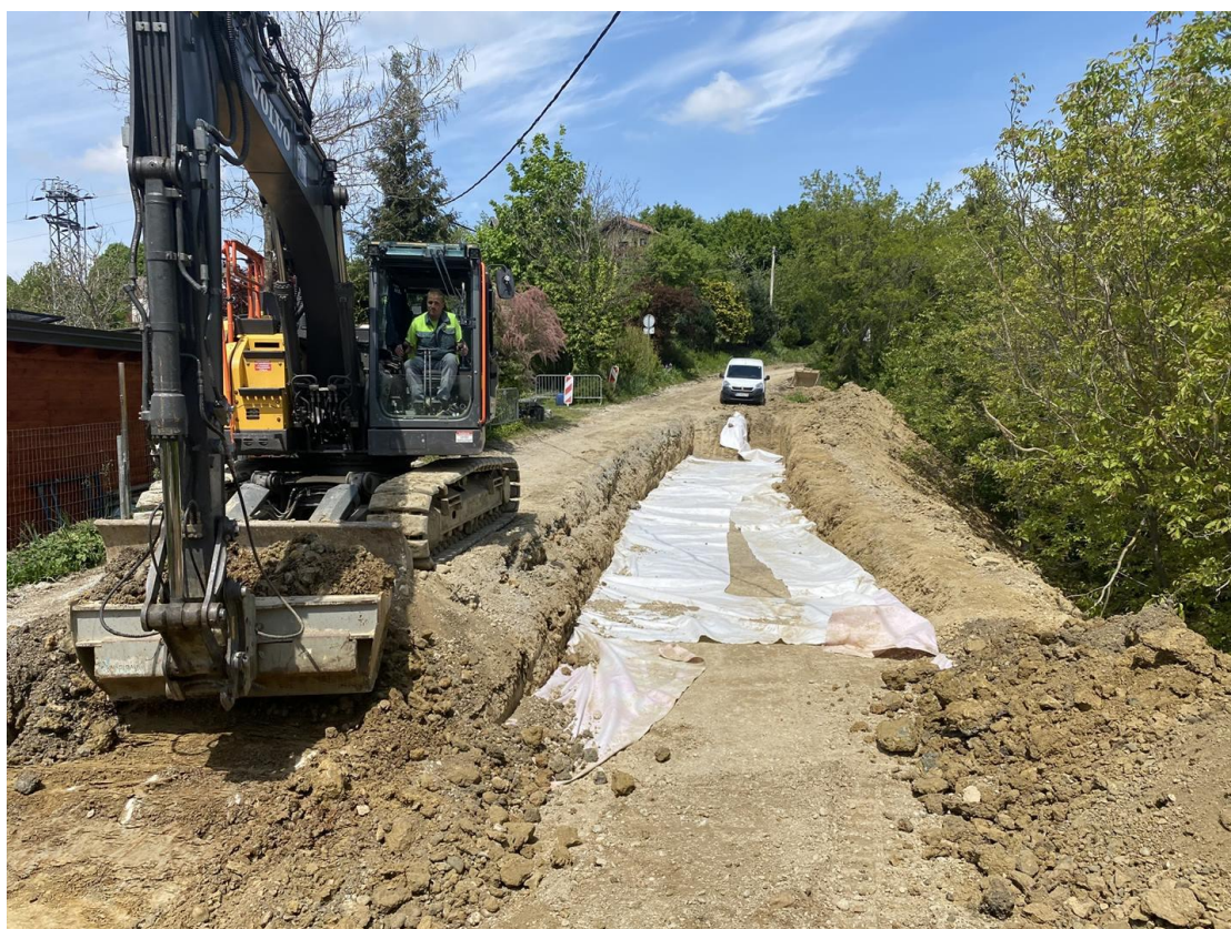
Slika.28. Ugradnja nosivog materijala u kolničku konstrukciju 2
