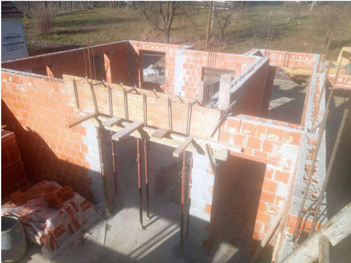
Slika 3.5.1. Prikaz montirane oplata
