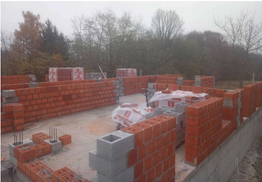
Slika 3.4.1. Zidanje nosivih zidova
