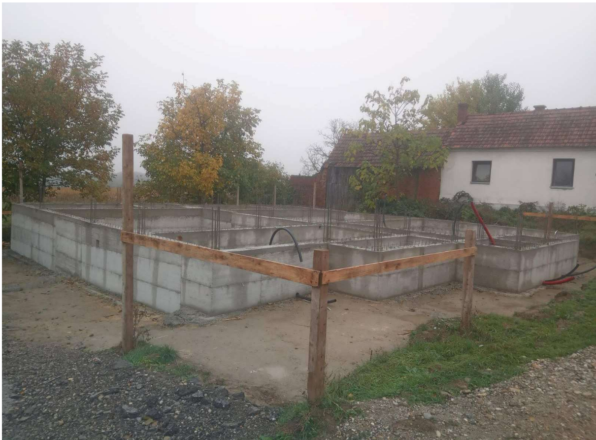
Slika 3.2.1. Betoniranje nadtemeljnih serklaža
