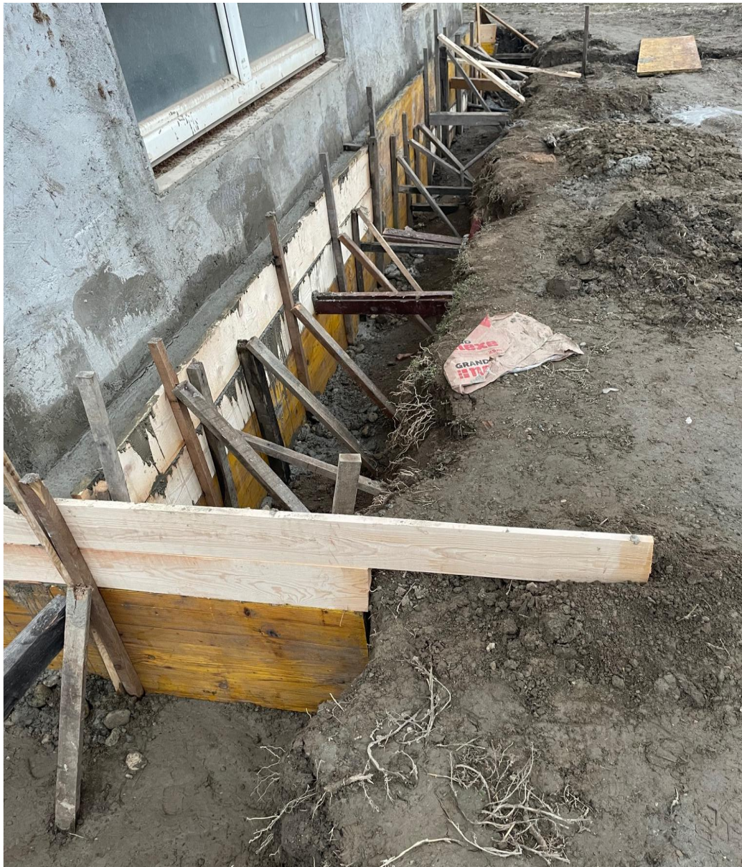
Slika 4.2 – Podbetoniravanje temelja
