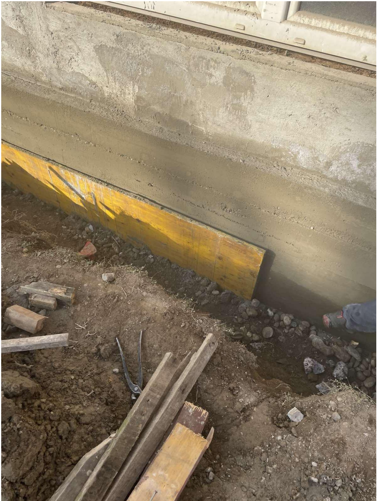
Slika 4.3 – Podbetonirani temelj
