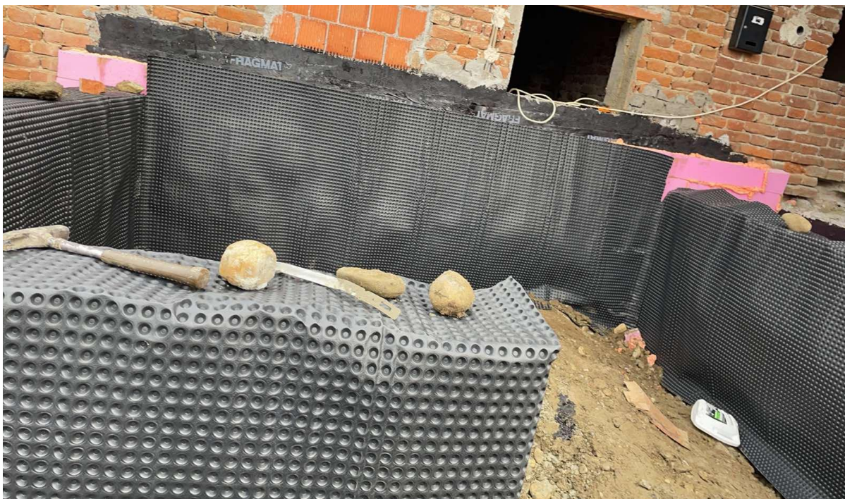
Slika 4.1 – Priprema za dogradnju ulaznog dijela građevina
