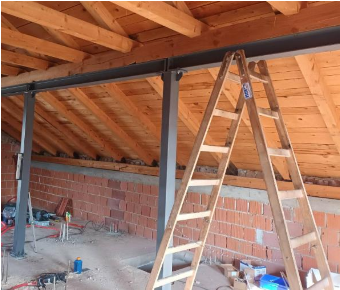
Slika 6.16 – Postavljeni HEA profili
