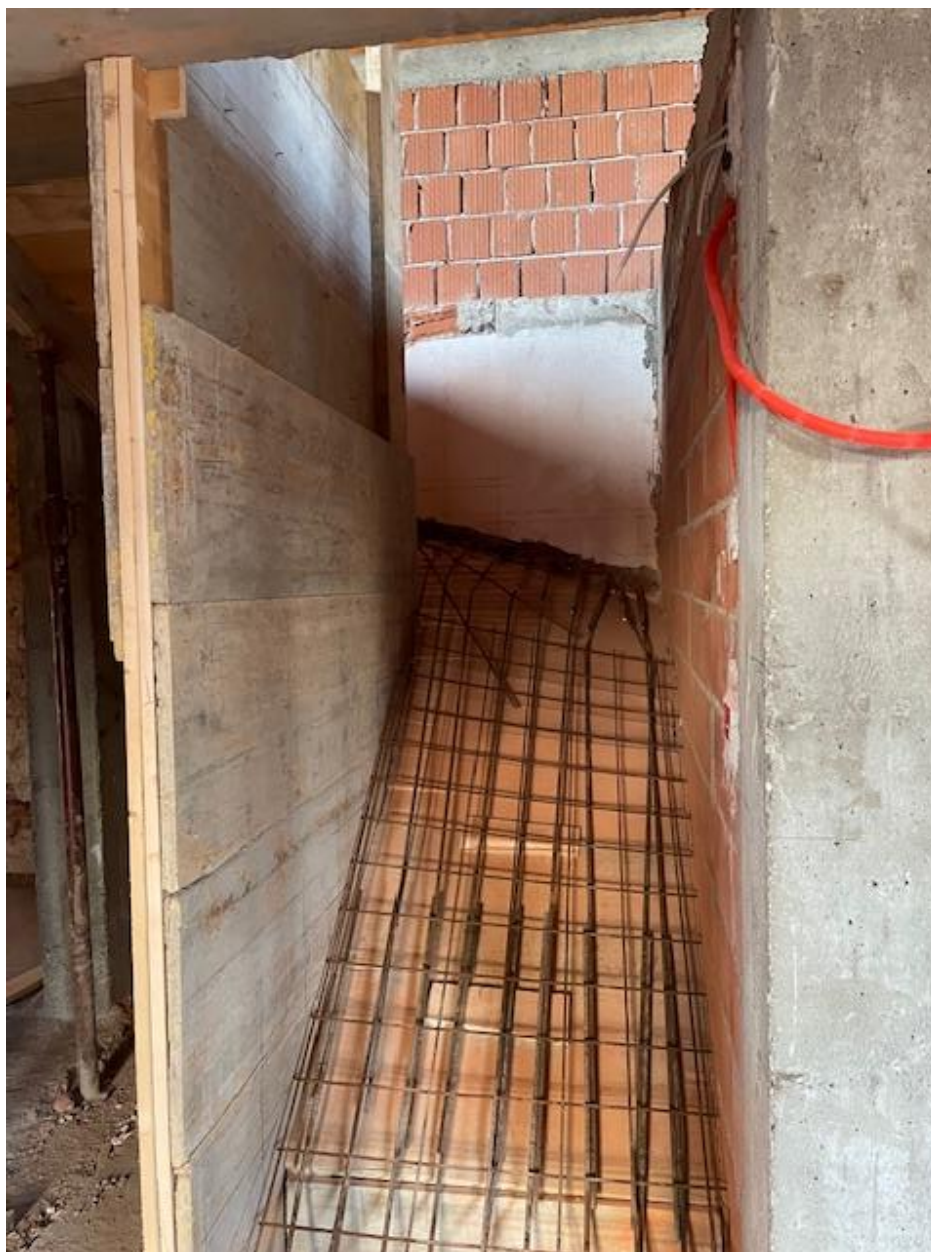
Slika 4.12 – Izrada novog stubišta
