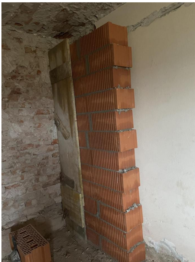
Slika 4.9 – Izrada novog nosivog zida
