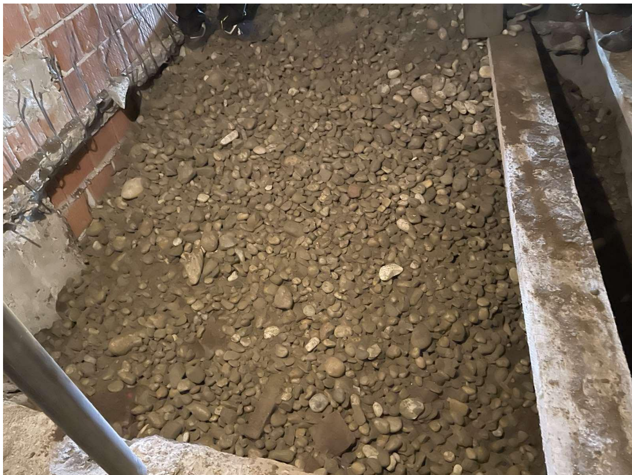
Slika 4.13 – Ispuna „slijepog podruma“
