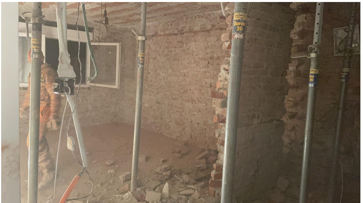
Slika 4.7 – Podupiranje postojeće konstrukcije
