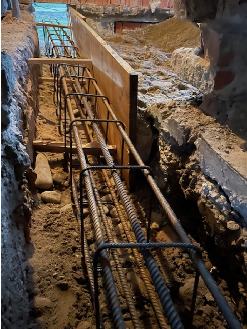
Slika 4.6 – Priprema temelja za povezivanje s dograđenim dijelom
