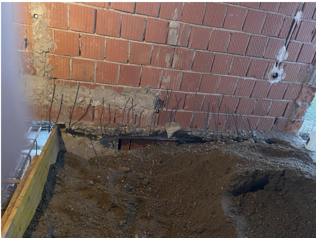
Slika 4.14 – Ispuna „slijepog podruma“ – drugi dio
