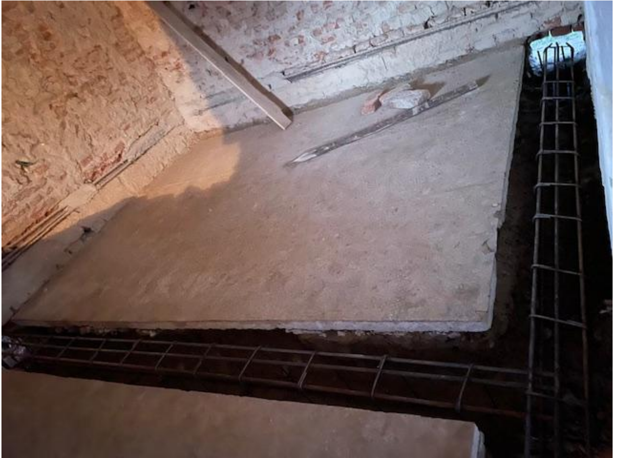
Slika 4.4 – Izrada trakastog temelja
