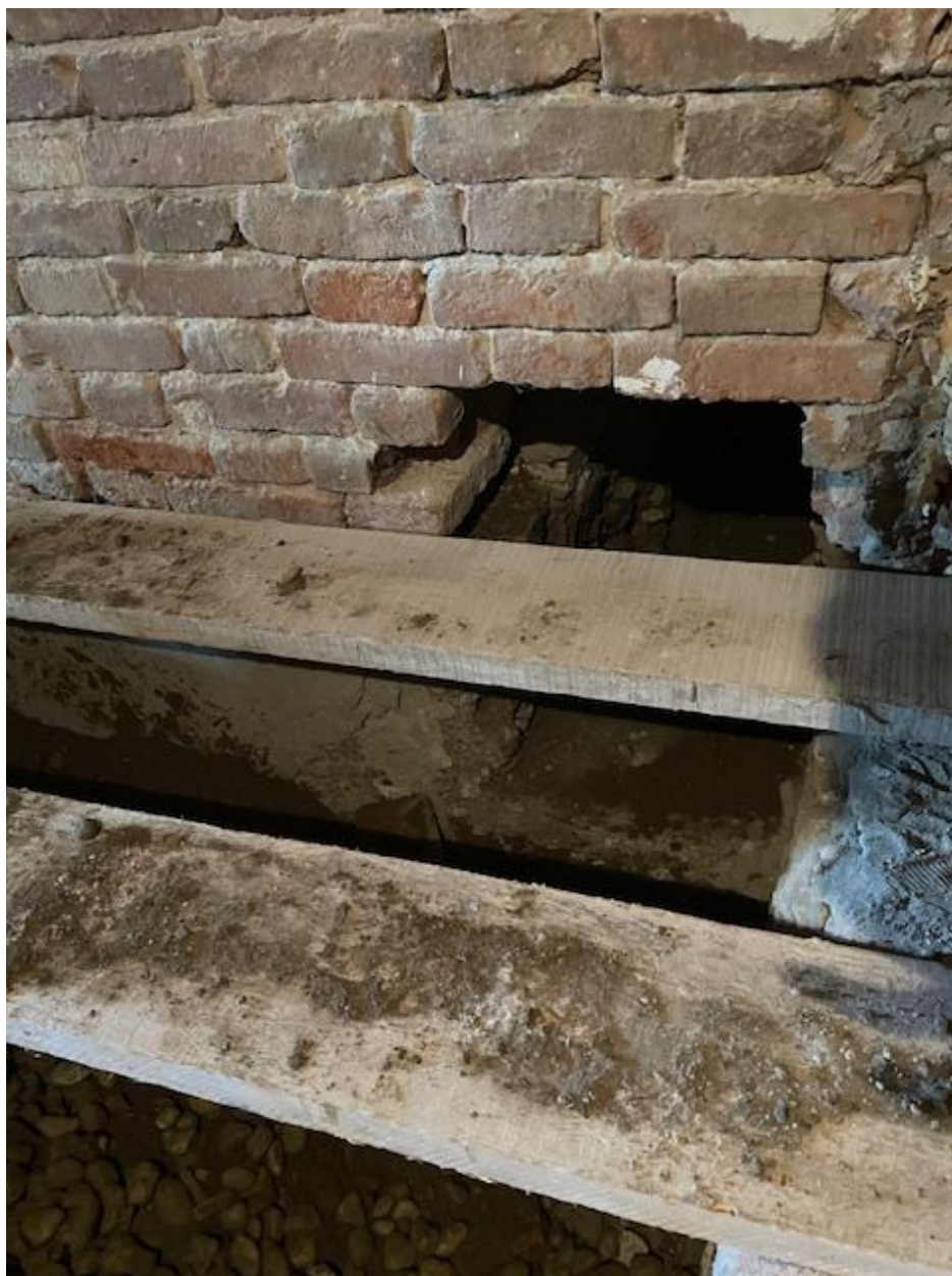
Slika 4.5 – Izrada temelja ispod postojećeg zida
