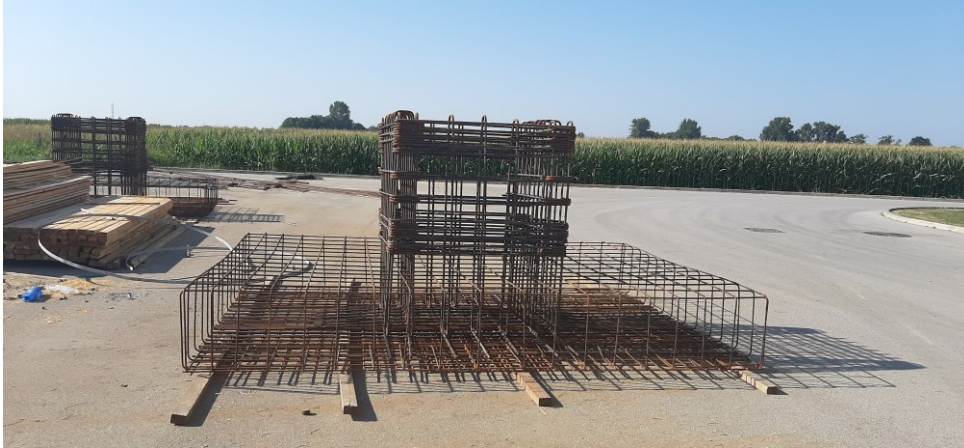
Slika 5 Armatura temeljne stope i čašice
