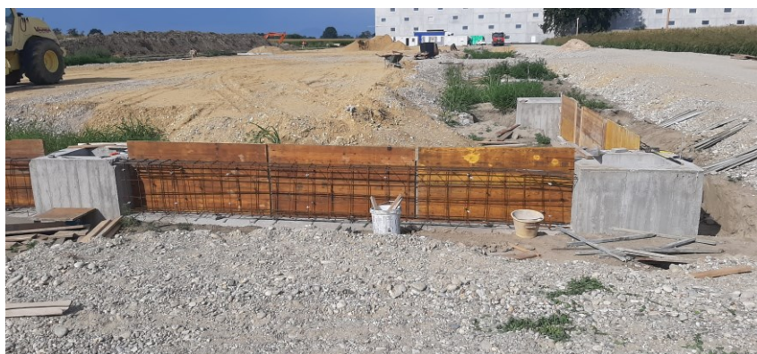
Slika 16 Oplata za betoniranje temeljnih traka
