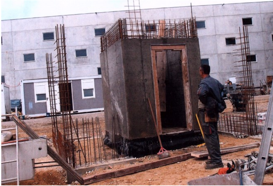
Slika 21 Hidroizolacija dizala
