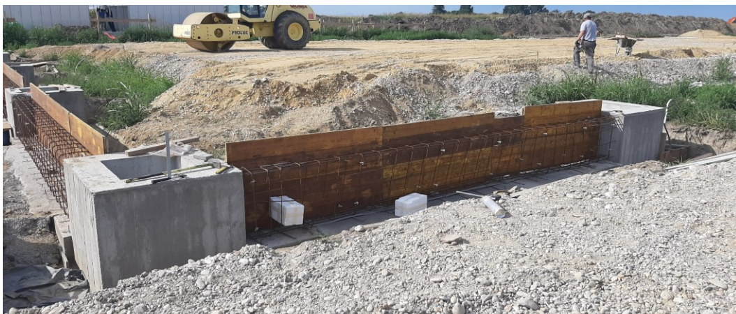
Slika 7 Priprema za betoniranje
