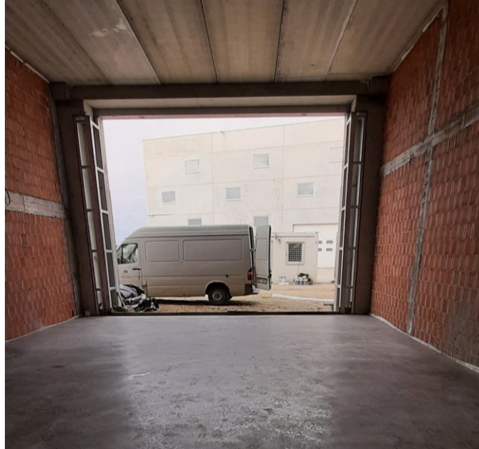
Slika 18 Zidovi u prizemlju
