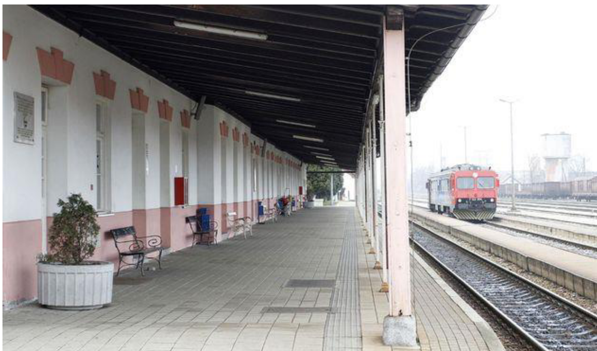
Slika 24 - Željeznički kolodvor Čakovec
