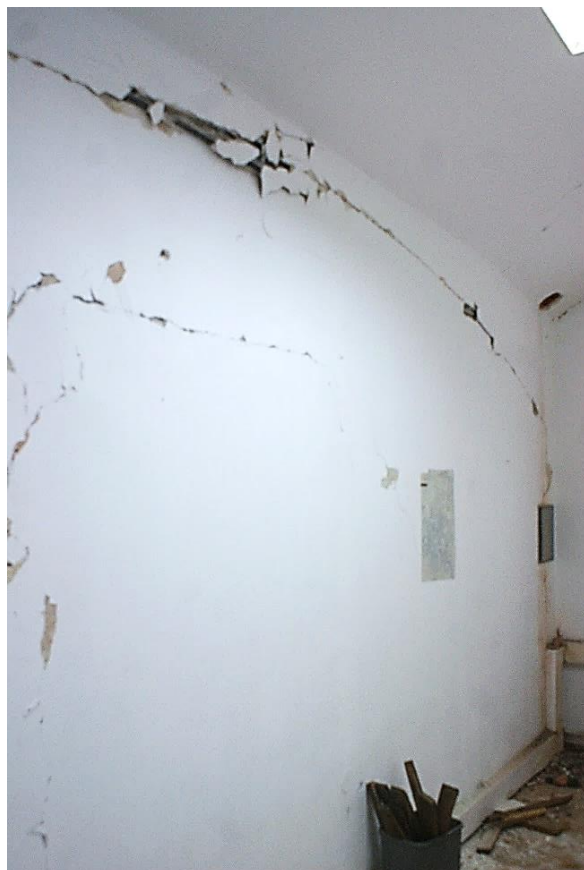
Slika 5.3 Prostorija 7. Horizontalna pukotina na zidu
