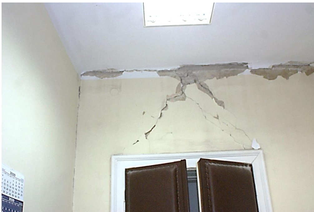
Slika 5.11 Prostorija 3. Oštećenje nadvoja
