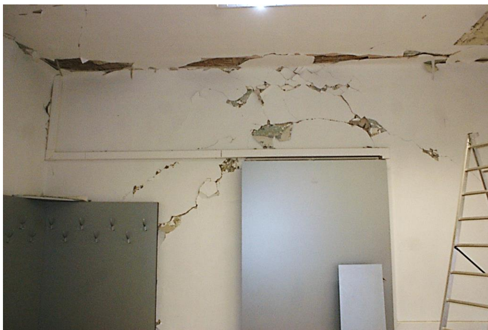
Slika 5.11 Prostorija 3. Oštećenje nadvoja
