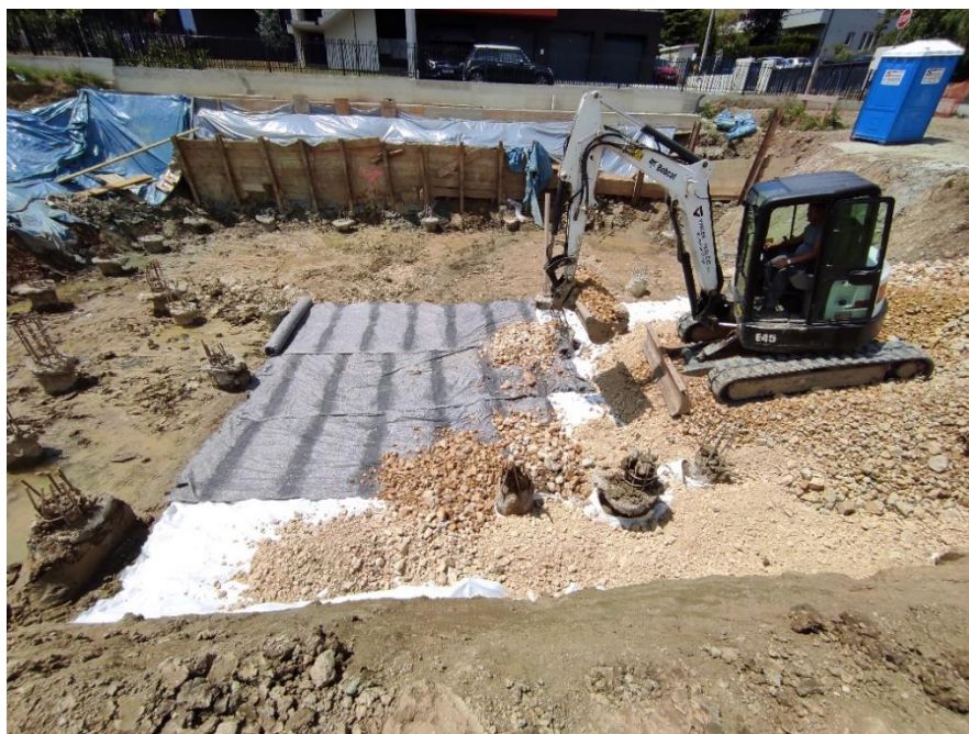
Slika 3.2.5.1. Ugradnja kamenog agregata
