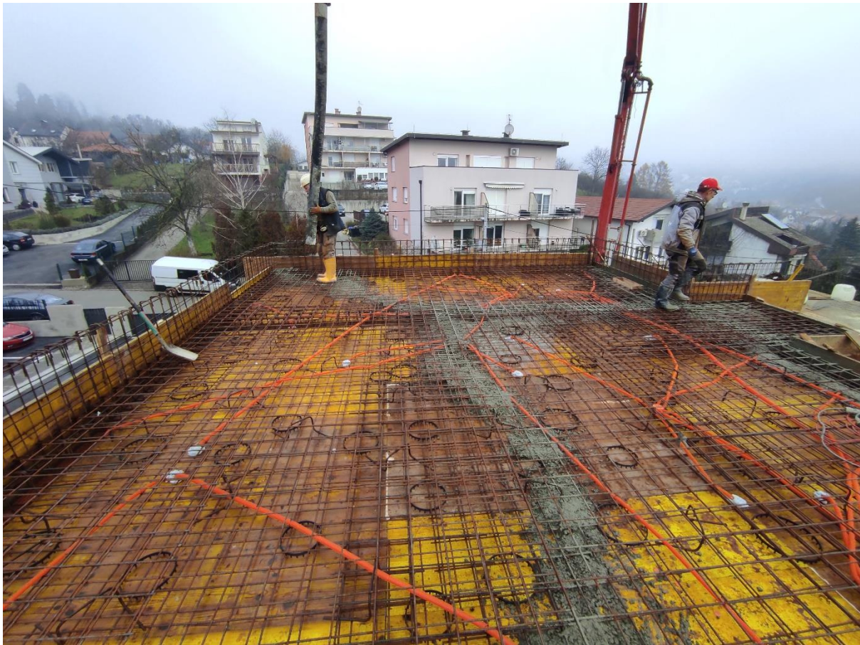
Slika 3.5.4.1. Betoniranje stropne AB ploče
