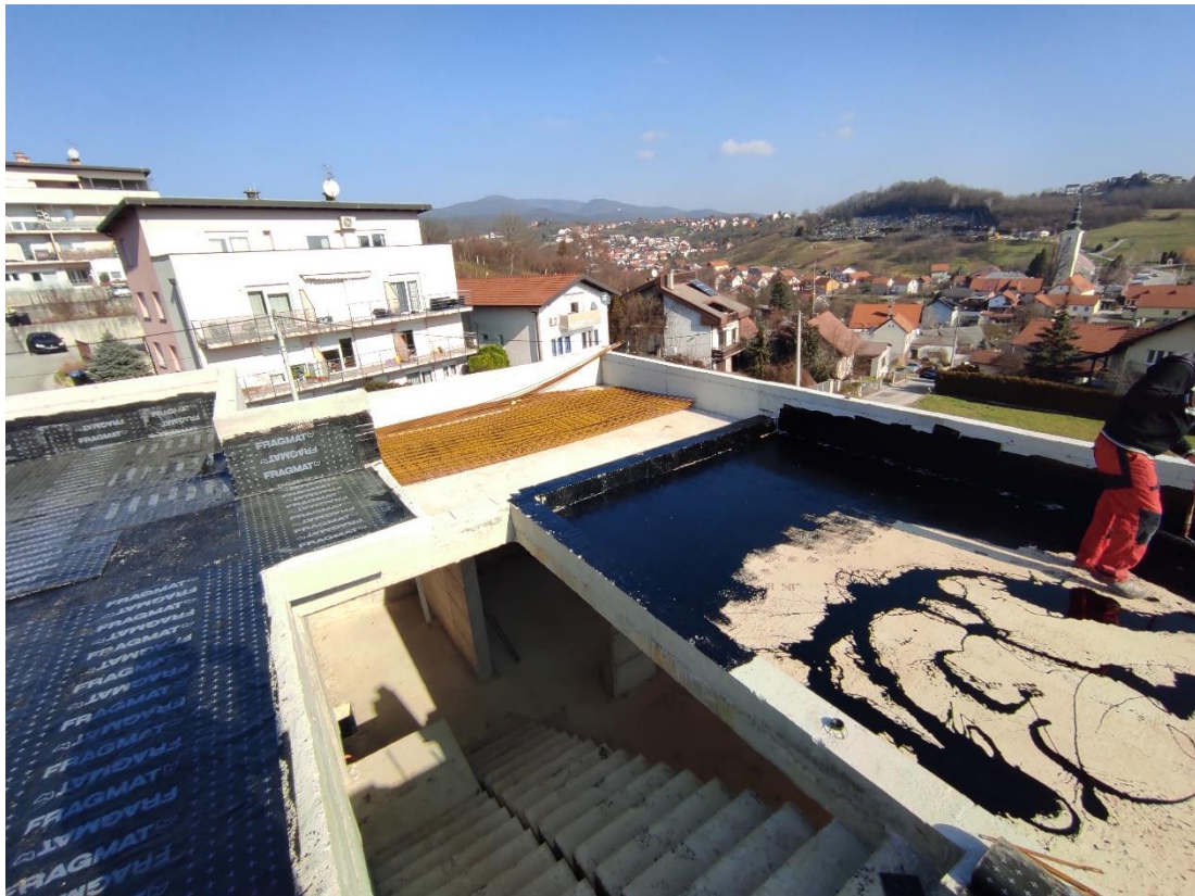
Slika 3.7.1.1. Nanošenje bitumskog premaza na betonsku podlogu
