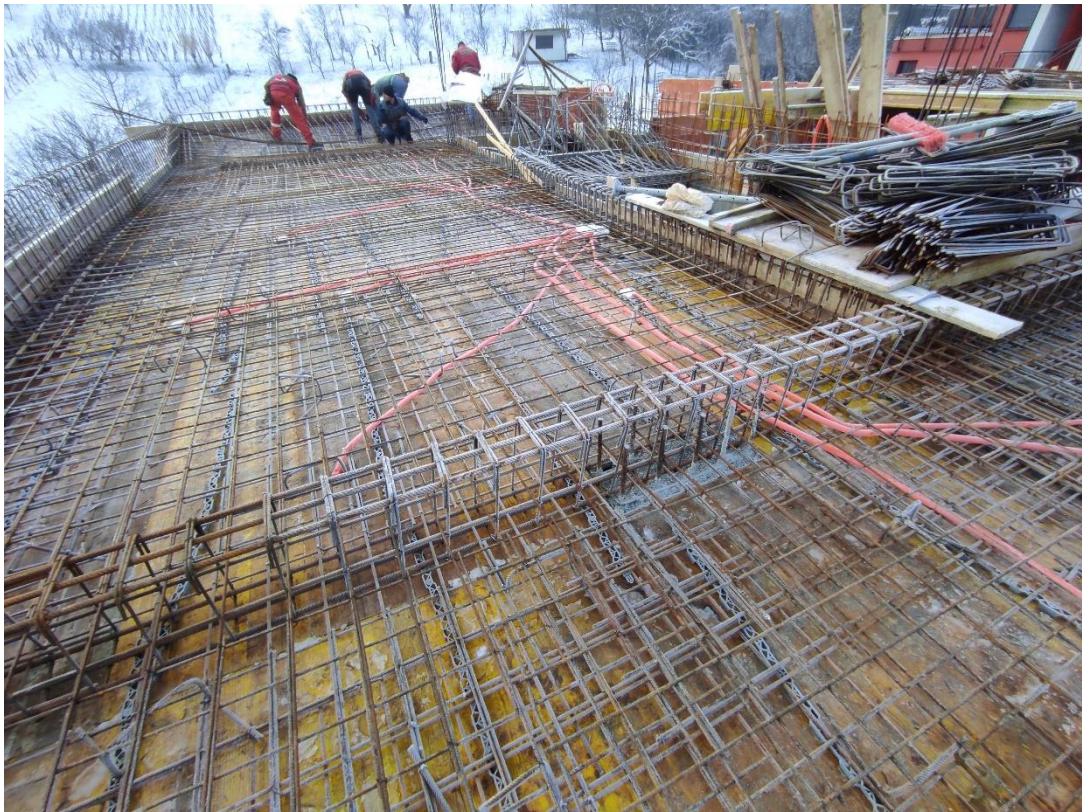
Slika 3.4.2. Postavljanje armature za stropnu ploču
