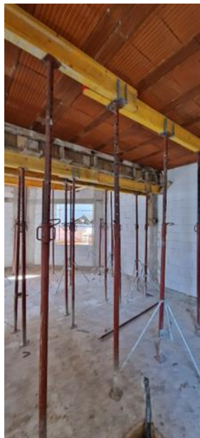
slika 3.3.3. postava oplata fert sustavom
