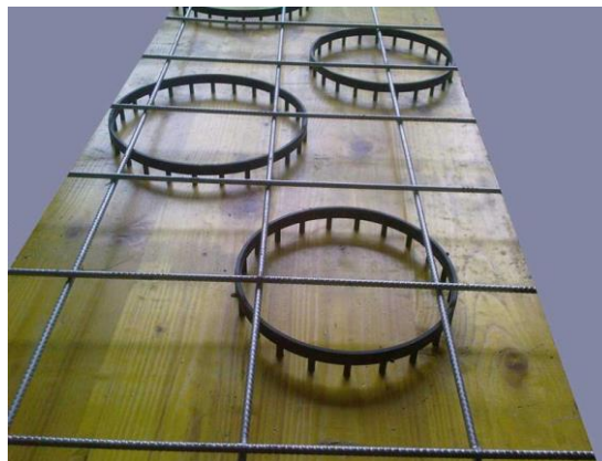
slika 3.4.1. prikaz armaturnih distancera
