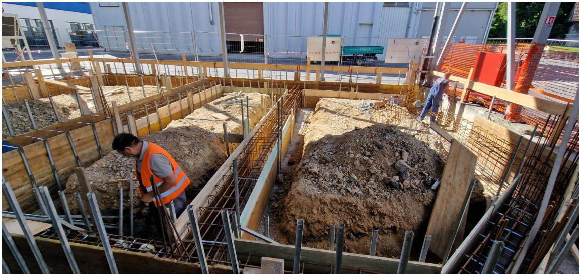
slika 3.4.2. prikaz postave oplate i armature za temelje
