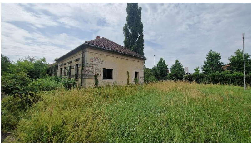
Slika 18. Istočno pročelje testne građevine
