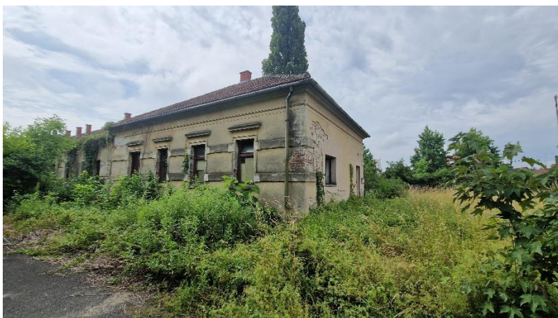
Slika 16. Sjeverno pročelje testne građevine
