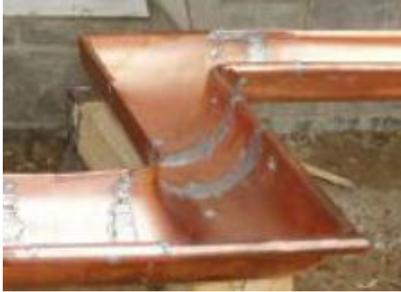
Slika 7.2. Lemljenje bakrene okapnice [6]
