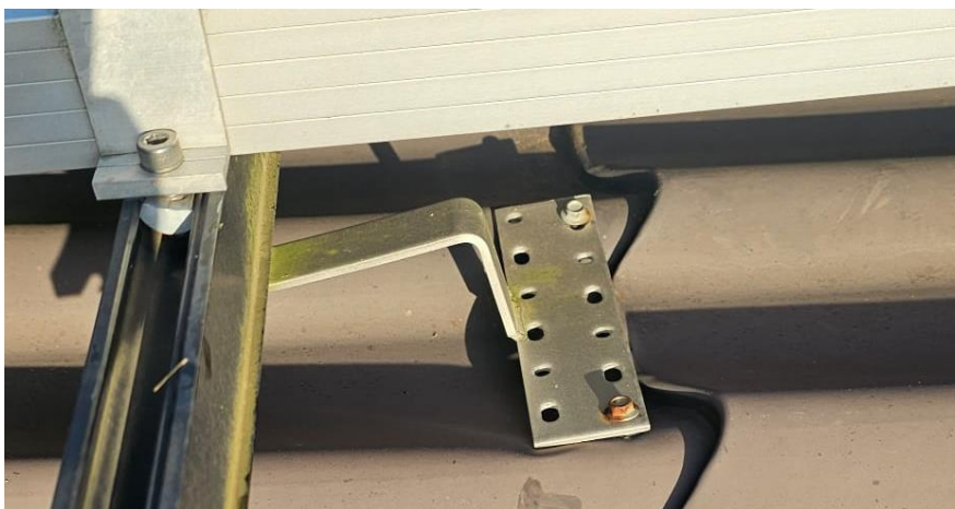
Slika 4.1. Potkonstrukcija za crijep montirana na limu
