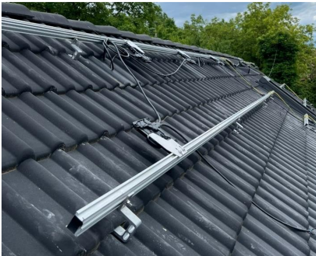
Slika 3.5. Potkonstrukcijski elementi za kosi krov popločen crijepom
