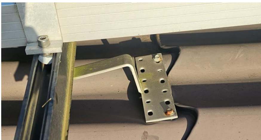
Slika 4.1. Potkonstrukcija za crijep montirana na limu
