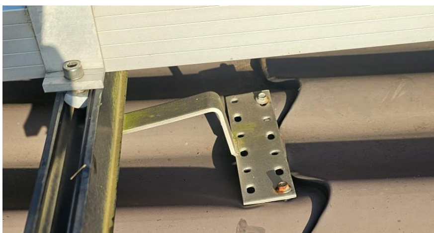
Slika 4.1. Potkonstrukcija za crijep montirana na limu
