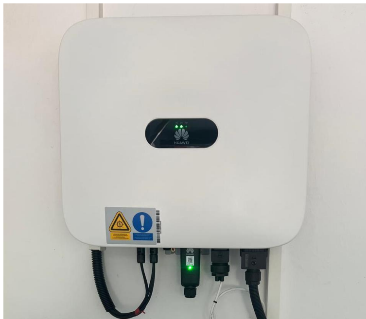
Slika 3.1. Huawei 10KTL centralni izmjenjivač
